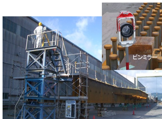
写真-1 TSによる自動計測状況
