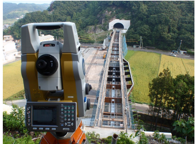
写真-2 高精度 TS による自動計測状況
