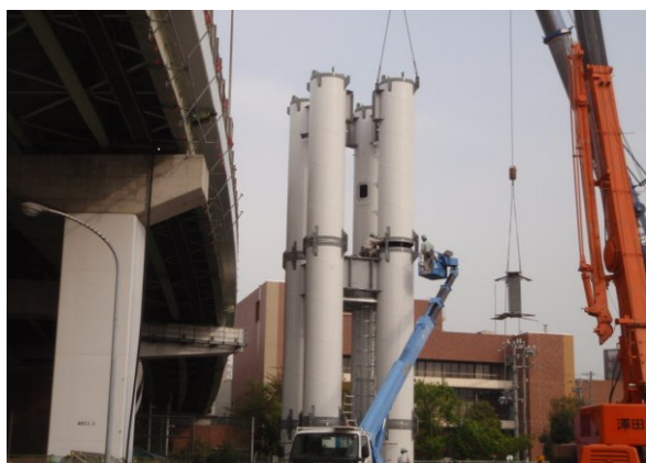
写真-3 PD4 架設状況
