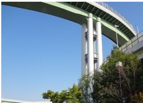
写真-2 PD4 鋼管集成橋脚
