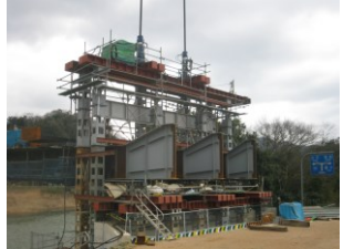
写真-5 A2吊下げ装置
