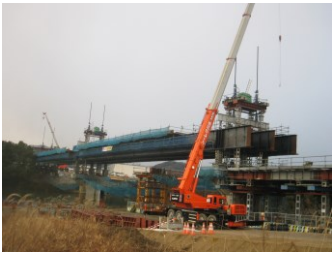
写真-3 降下作業前
