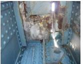
②アンカーから樹脂を注入し、予め設けた注入材導入 溝を用いて全面に拡散させ、既設床版とポリマーセメン トモルタルを一体化させる.しかし、クラックに樹脂が 注入されるか疑問であったため、試験体によって注入さ れているか確認した.さらに実橋でも一部コアを採取し、 注入確認を行った().
