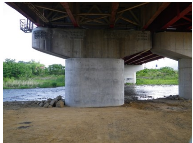
写真-5 橋脚巻き立て（施工完了）
