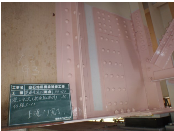
写真-12 P3 桁端補修（補修後）
