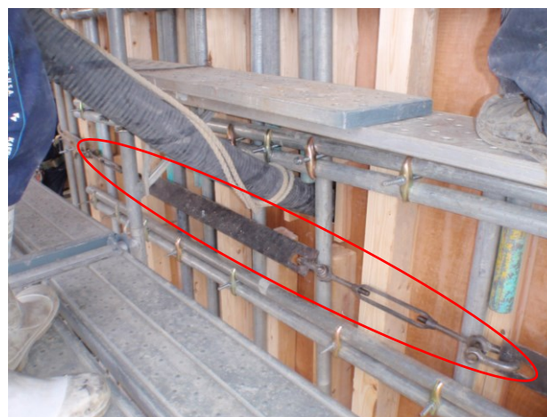
写真-2 橋脚巻き立て帯型治具設置状況
