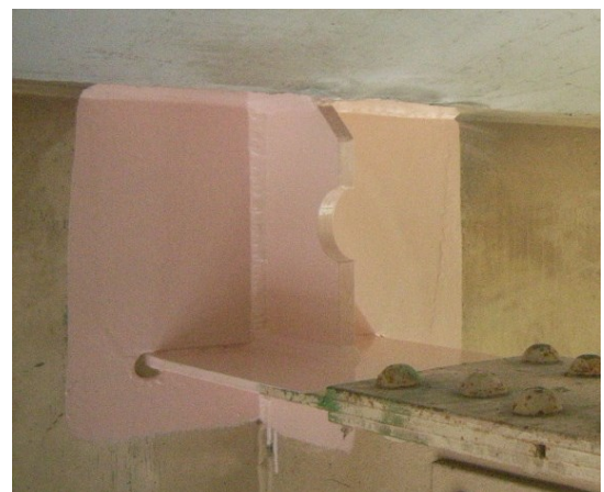
写真-10 ウェブギャップ板取替え(補修後)
