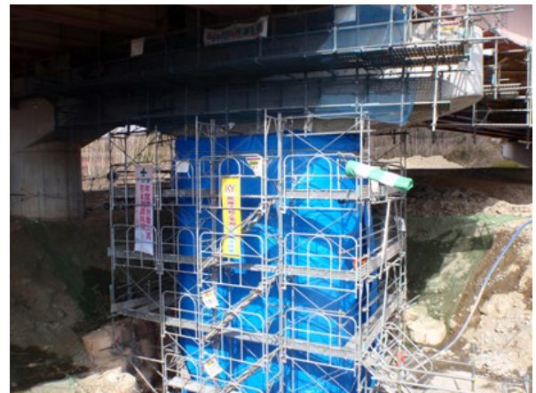
写真-4 巻き立てコンクリートの養生状況
