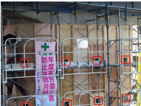
写真-3 橋脚巻き立て打ち込み用兼パイプレーター用窓設置状況
