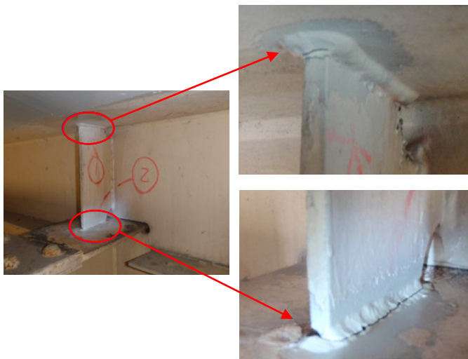
写真-9 ウェブギャップ板(補修前)
