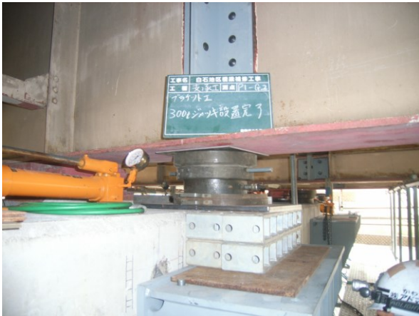
写真-8 ジャッキ設置状況
