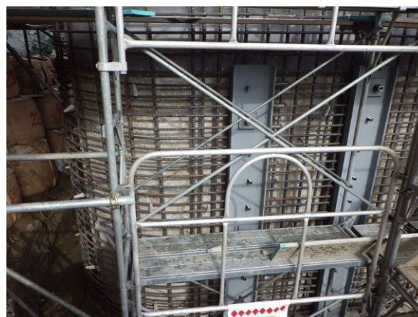
写真-1 現場の PC 鋼棒配置
