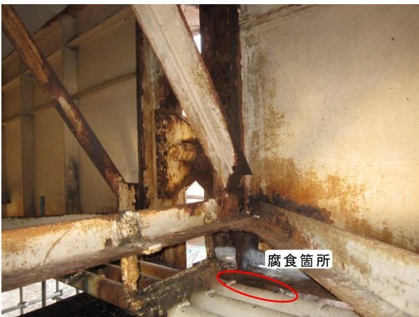
写真-11 P3 桁端補修（補修前）
