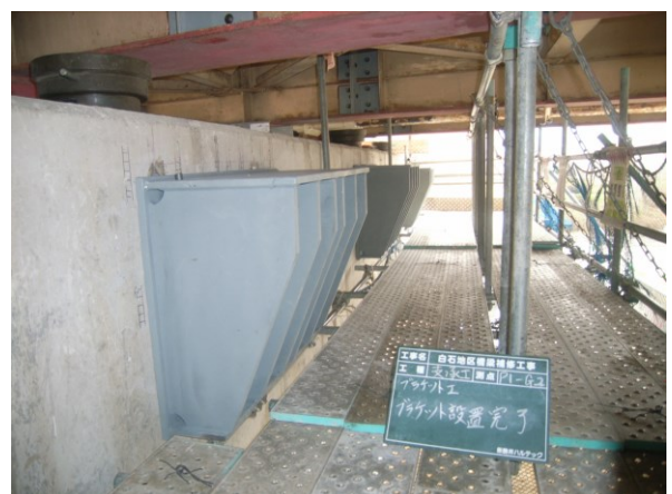
写真-7 鋼製ブラケット設置状況
