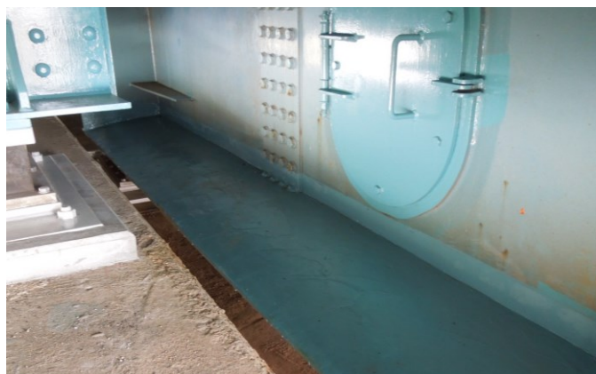
写真-14 箱桁端部の修復完了状況
