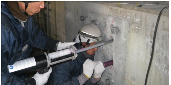
写真-9 樹脂注入状況
