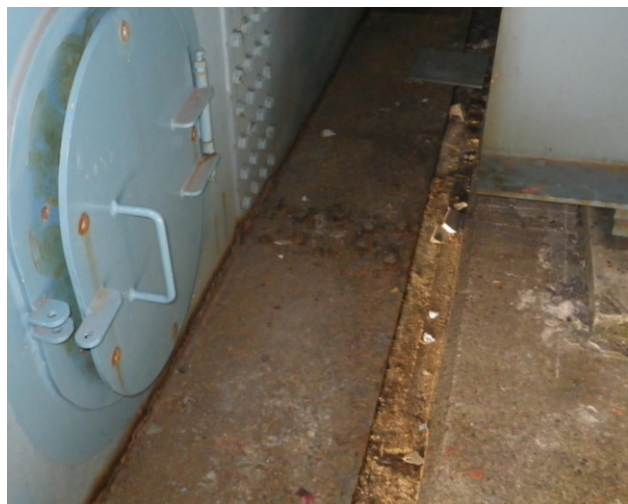
写真-3 箱桁端部の腐食状況
