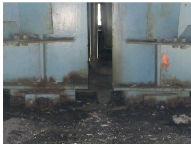
写真-2 鈹桁部支承の状況
