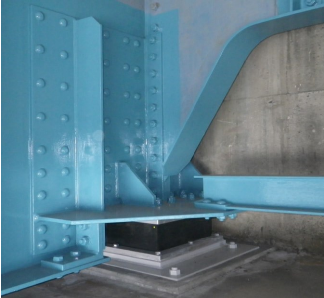
写真-5 桁端部の作業完了状況
