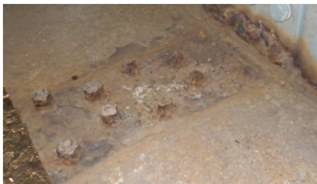
写真-4 箱桁端部の添接部の腐食状況
