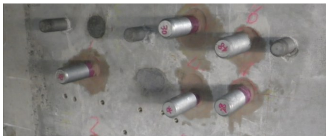
写真-11 Rアンカー定着完了状況
