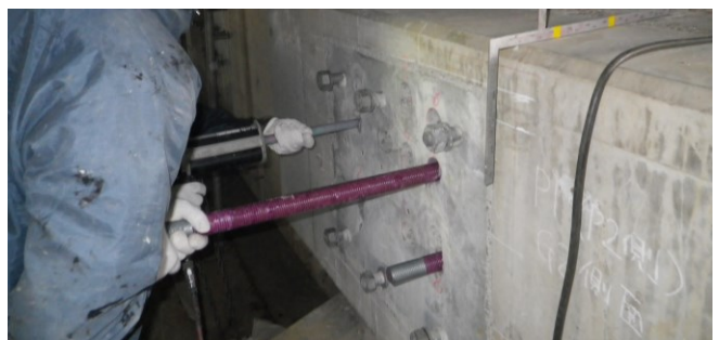
写真-10 Rアンカー挿入状況
