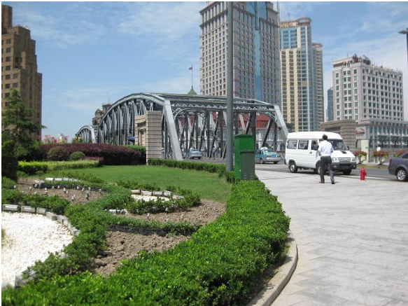
写真-9 外白渡橋
