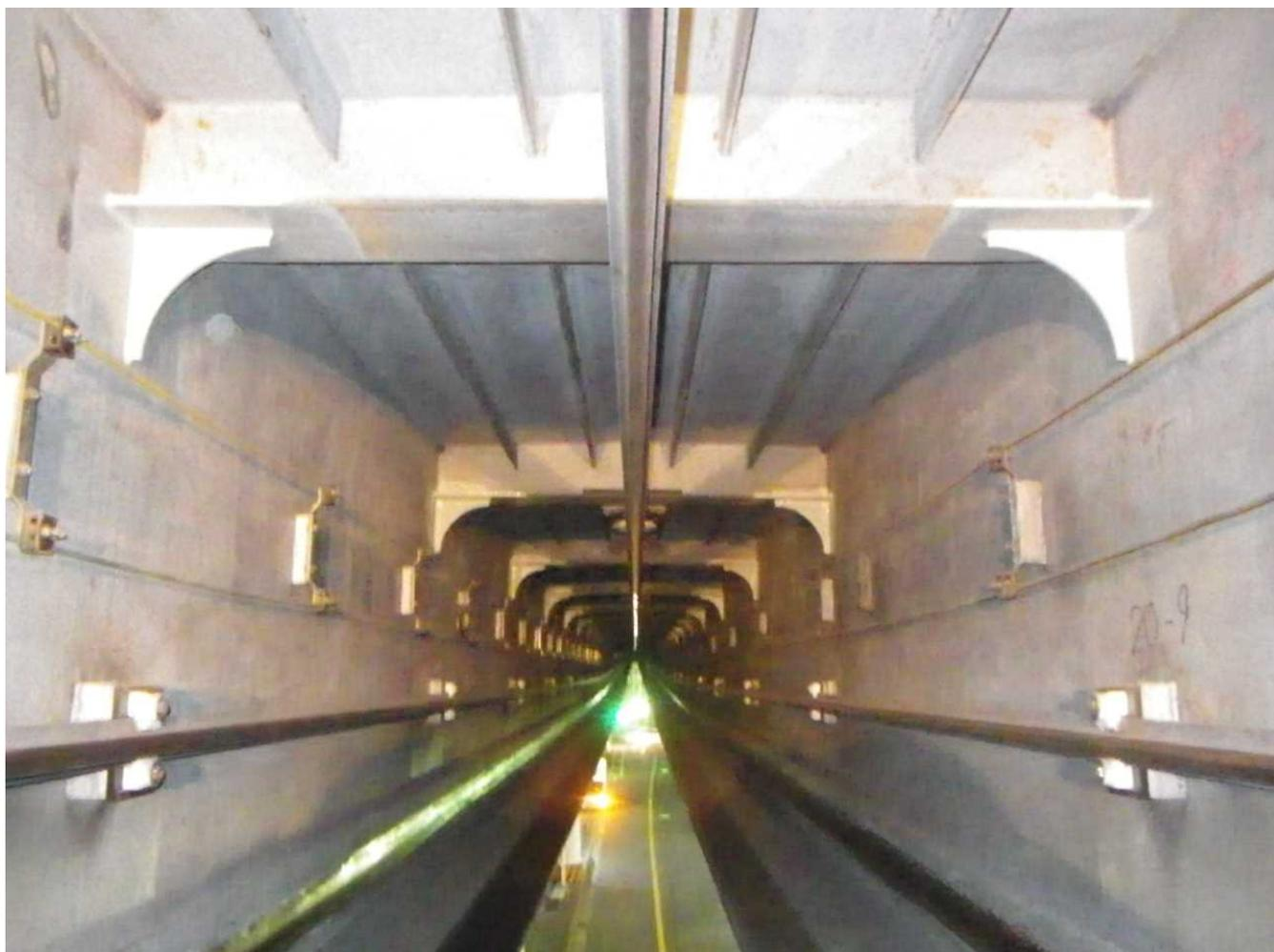
④ 湘南モノレール軌道桁隅角部補強工事
