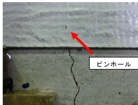
写真-7 AZX1 ピンホール拡大図 (ひび割れ幅 1.7mm)
