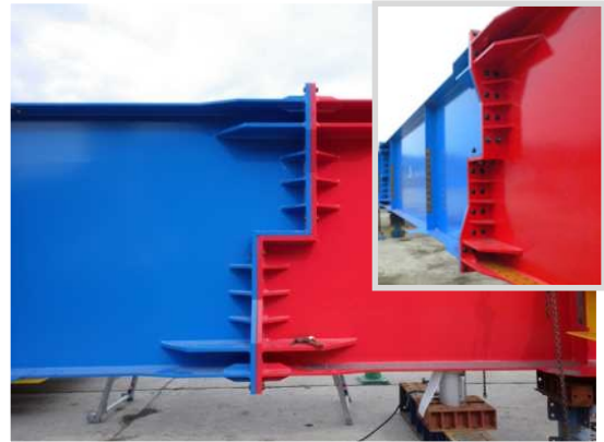
写真-1 連結部構造
