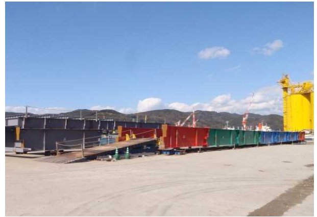
写真-4 組立て状況 (和歌山工場)
