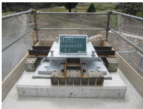
写真-3 P1 橋脚固定装置（橋軸・橋軸直角方向共に固定）
