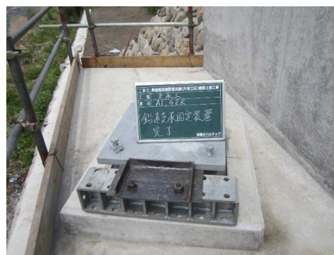
写真-4 A1 橋台固定装置（橋軸直角方向の固定）
