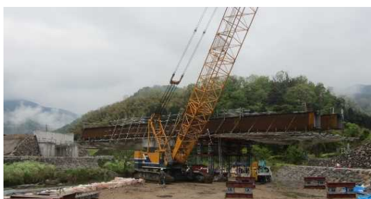
写真-2 バランシング架設状況
