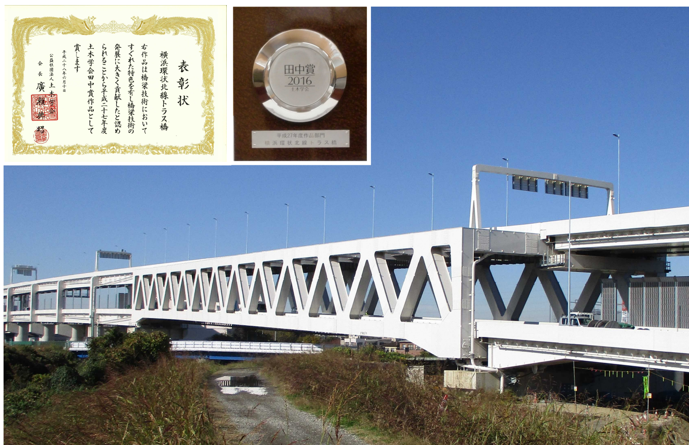
橋梁が地域の方々に親しまれるよう「大熊川トラス橋」と平成28年8月に命名された
