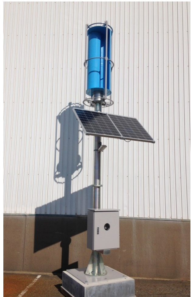
写真-1 システムの設置状況
