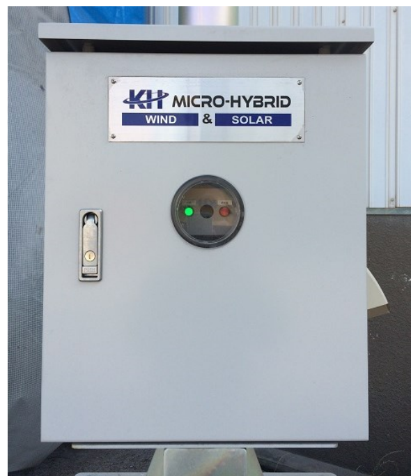
写真-3 制御ボックス
