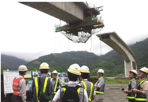
写真-7 現場見学(PC橋建設現場)
