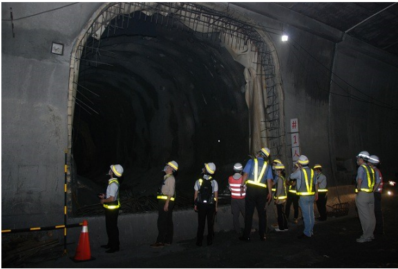
写真-6 現場見学(トンネル建設現場)
