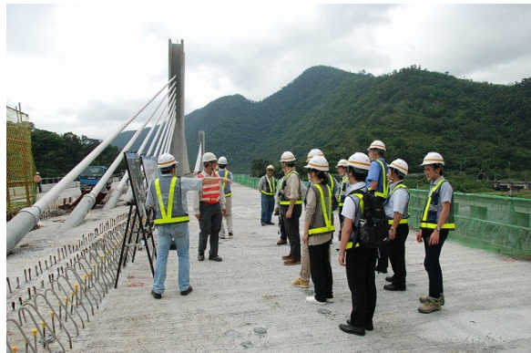
写真-5 現場見学(エクストラロード橋建設現場)
