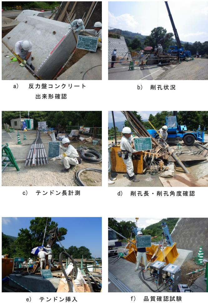
写真-2 グラウンドアンカーの施工状況写真
