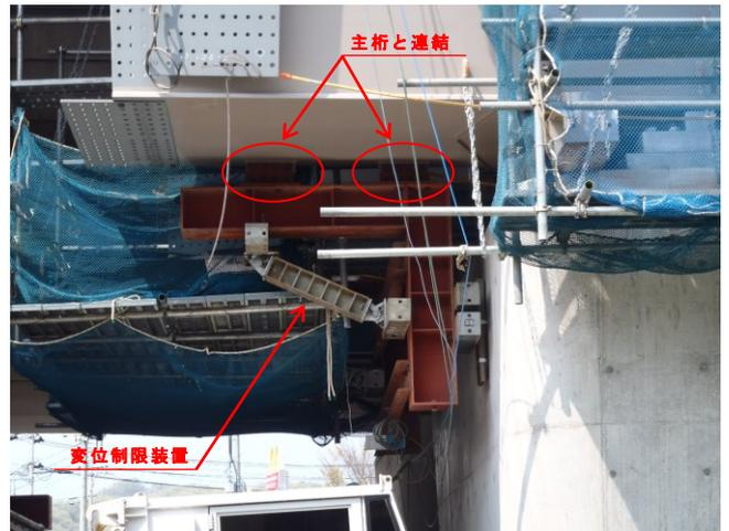
写真-4 橋軸方向変位制限装置
