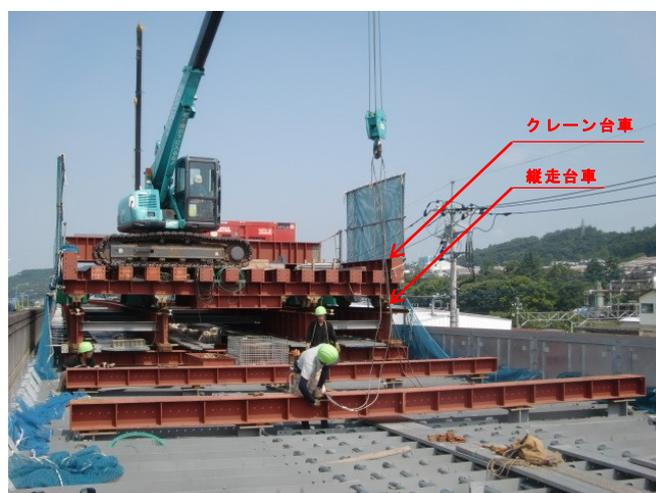
写真-7 軌条設備撤去状況
