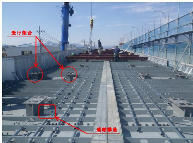
写真-6 軌条設備架台設置状況
