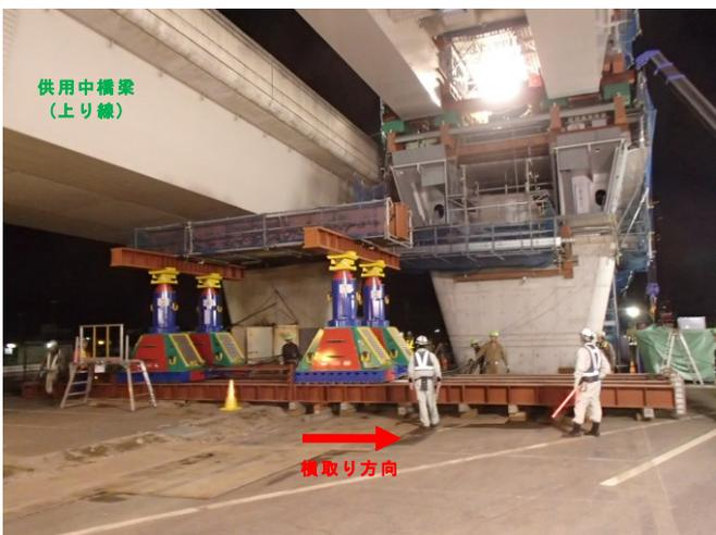
写真-3 後方側降下装置横取り状況写真
