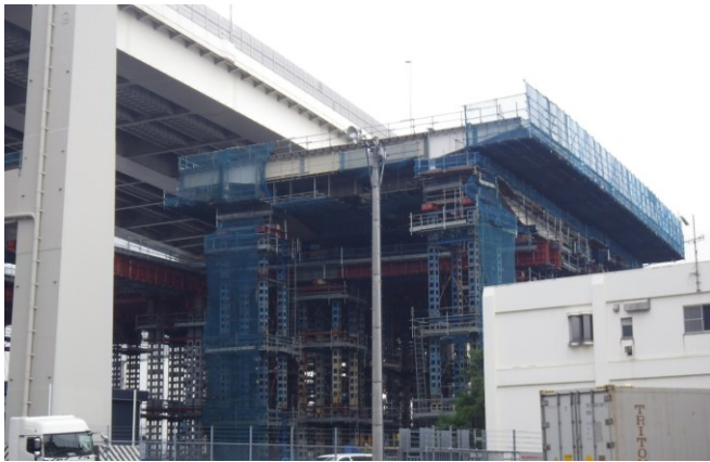
写真-14 横取り・縦取り桁地組立
