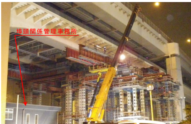
写真-16 工事桁撤去状況
