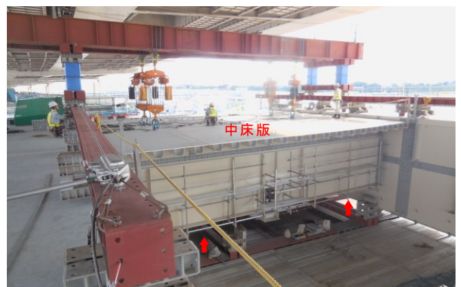
写真-4 門型吊上げ設備による中床版吊上げ
