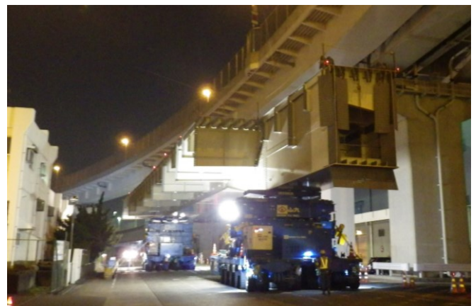
写真-18 多軸台車による桁運搬（埠頭内道路）
