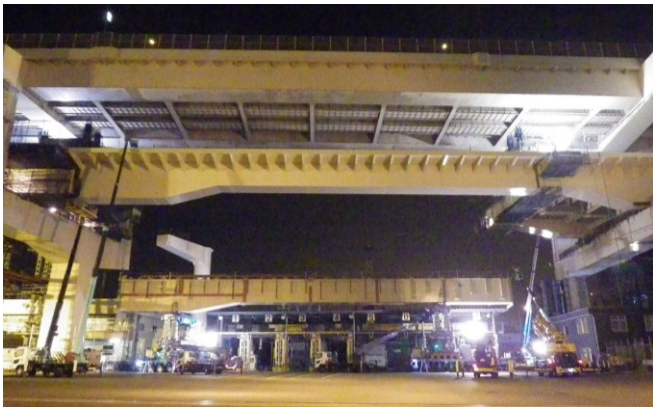
写真-19 吊り桁のリフトアップ（埠頭施設の回避）
