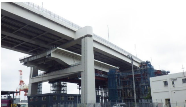
写真-15 横取り・縦取り架設完了
