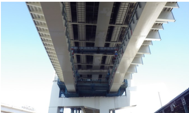
写真-20 主桁吊上げ完了
