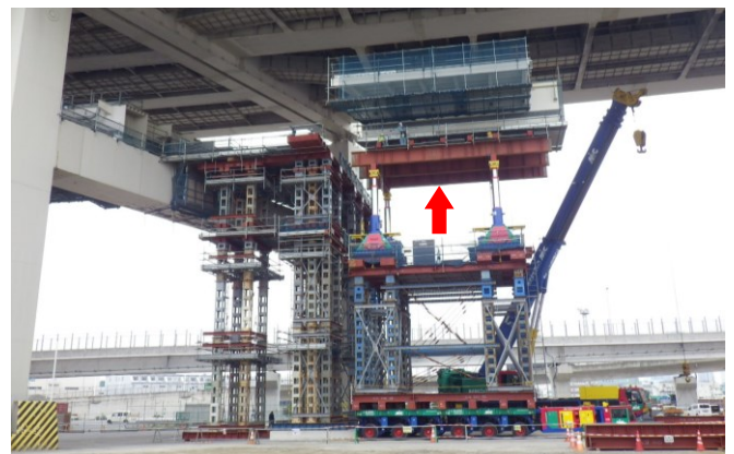
写真-1 地組立およびリフトアップ（G1 桁）
