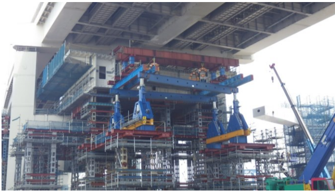
写真-5 中床版吊上げ用門型設備のリフトアップ
