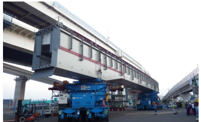
写真-17 多軸台車による桁運搬（地組ヤード）
