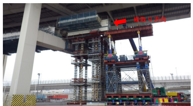
写真-2 リフトアップ架台上的縦取り（G1 桁）
