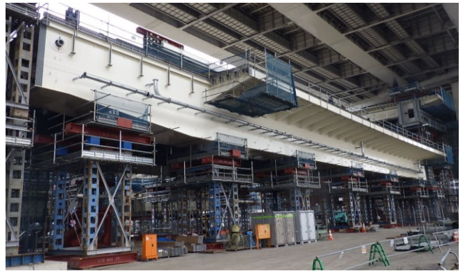
写真-7 P8～P7 間吊上げ前
