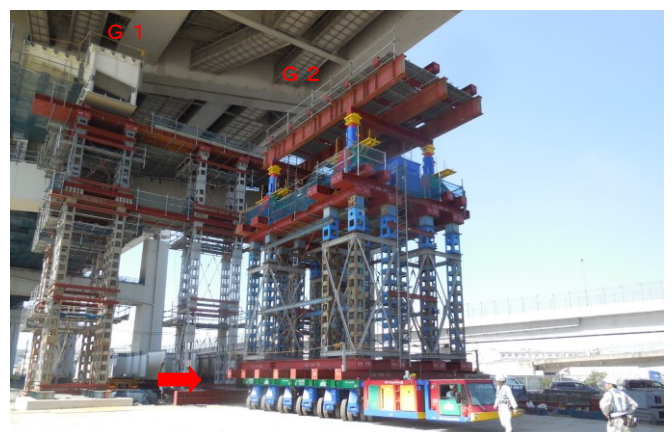
写真-3 リフトアップ架台の盛替（G1 桁から G2 桁へ）
