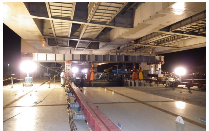
写真-23 中床版吊上げ設備
