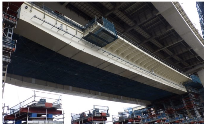
写真-8 P8～P7 間吊上げ後
