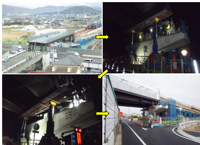
写真-5 夜間降下作業
