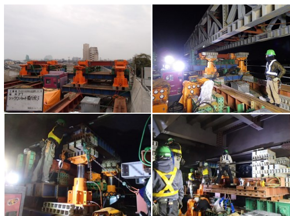
写真-2 盛替え設備
