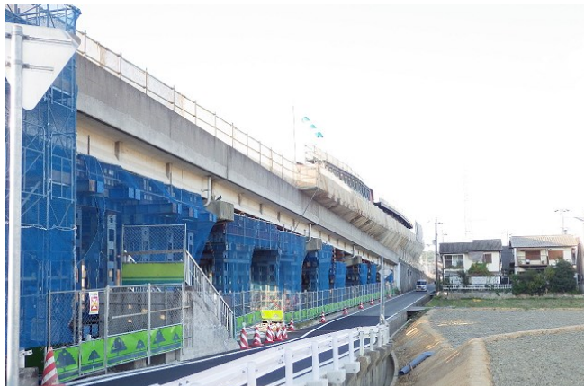
写真-3 既設 PC 桁受けベント
