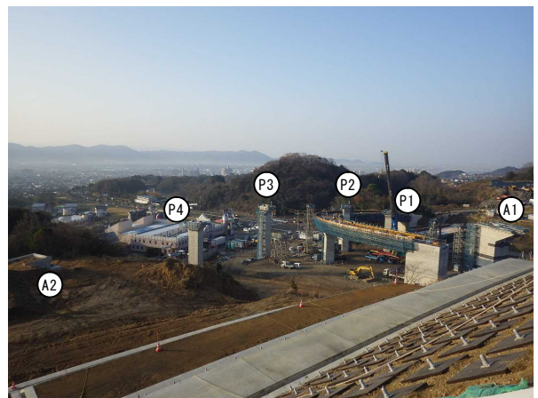
写真-5 現場着手時のヤード状況
