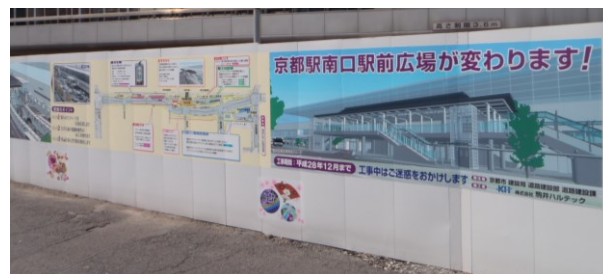
写真-6 仮囲いとイメージアップ
