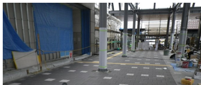
写真-10 タイル施工状況
