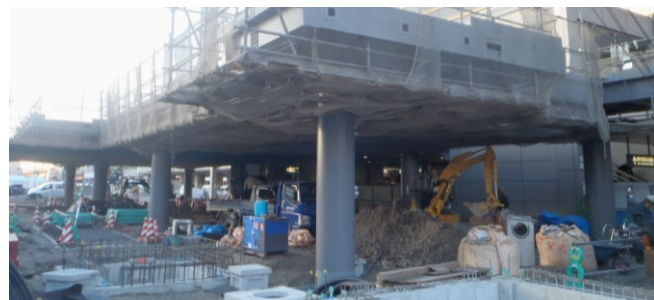
写真-9 架設完了
