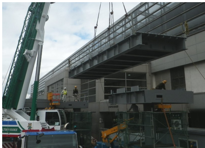
写真-7 架設状況（デッキ）
