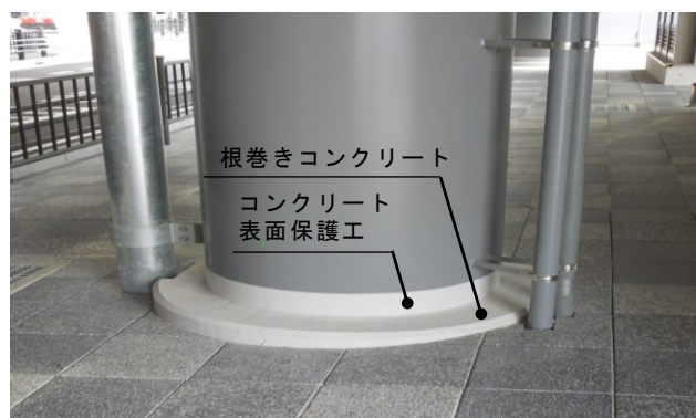
写真-5 表面保護状況
