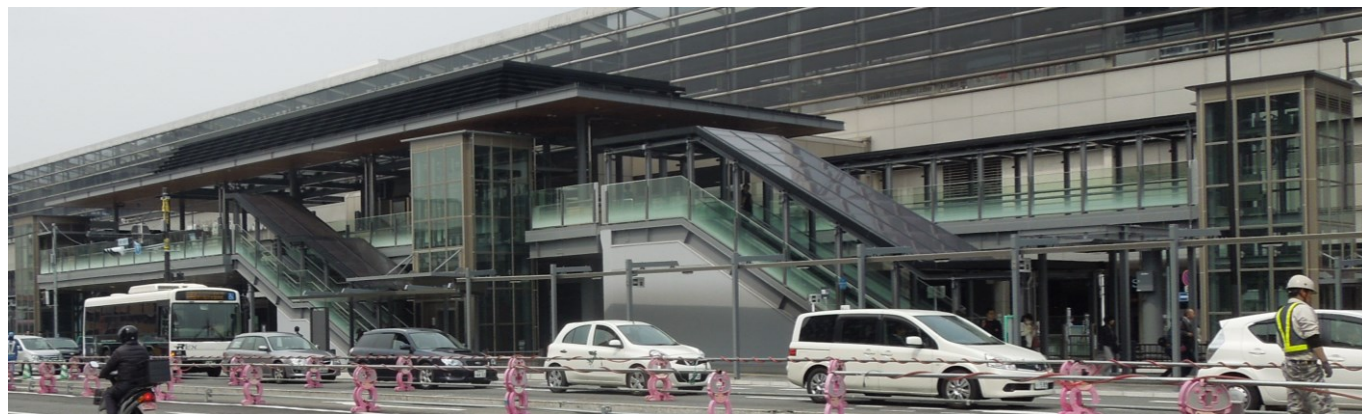
写真-1 正面全景
