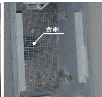
写真-4 金網の設置
