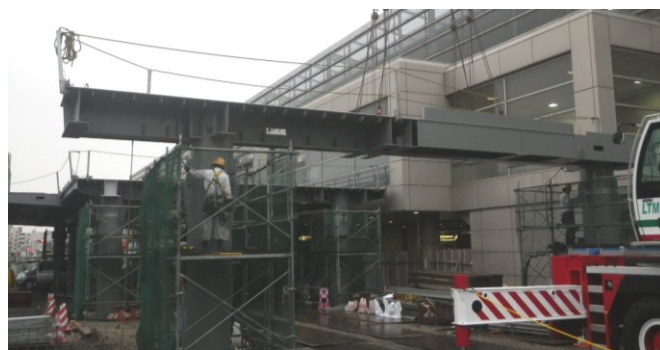
写真-8 架設状況（横桁）
