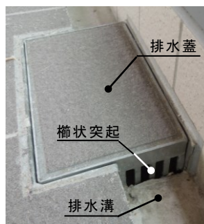
写真-3 排水柵蓋
