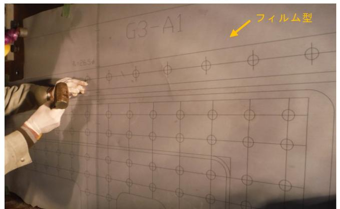
写真-6 既設部材の切断（フィルム型の使用）
