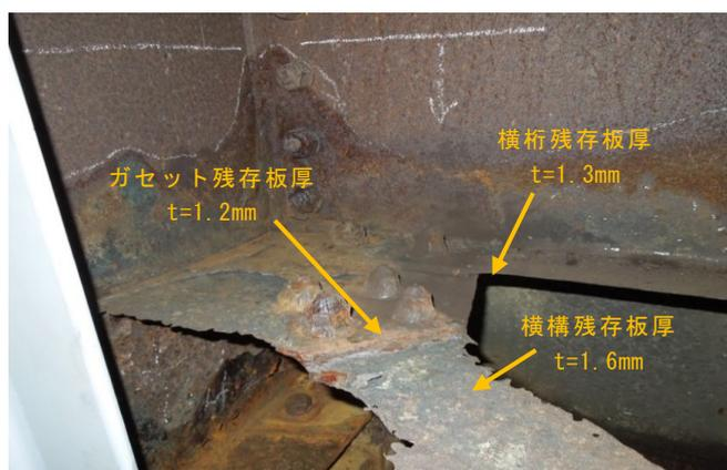
写真-2 腐食損傷状況
