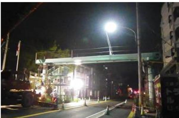
写真-4 通路桁架設状況
