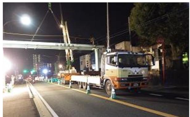
写真-3 通路桁撤去状況
