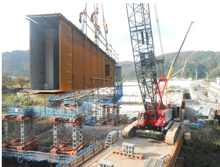
200t 吊クローラークレーンによる主桁架設
