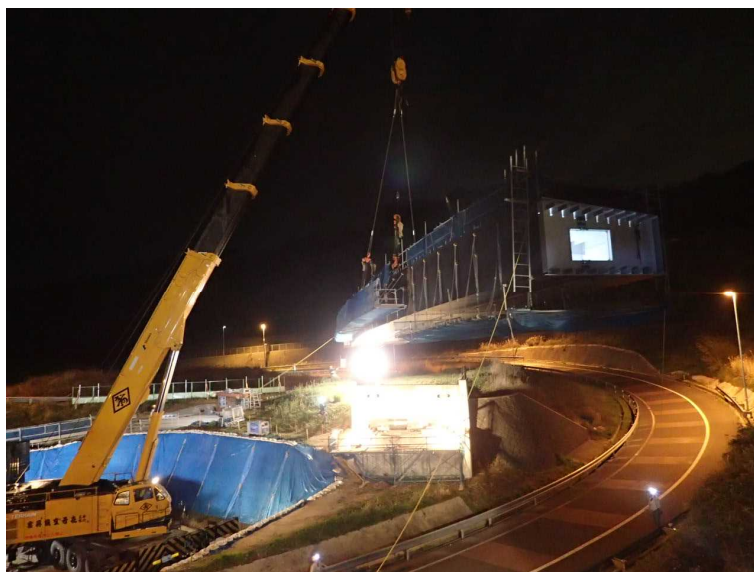
550t 吊トラッククレーンによる主桁架設
