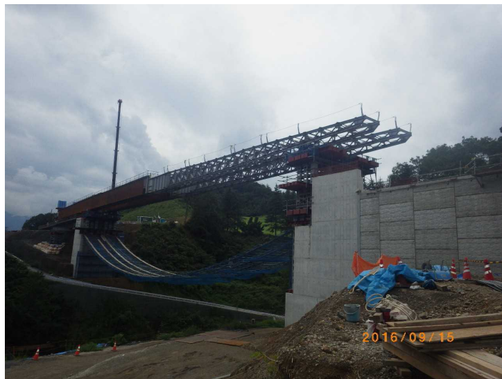
手延機による送出し架設
