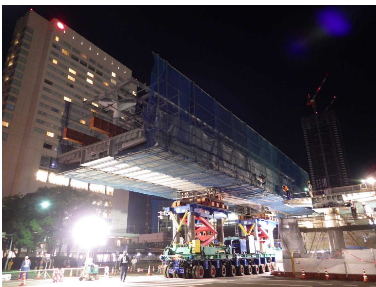
自走多軸台車と特殊ジャッキを用いた一括架設
