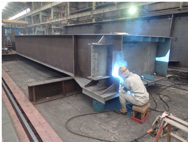
工場での主桁溶接作業状況
