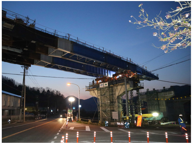
手延機による送出し架設
