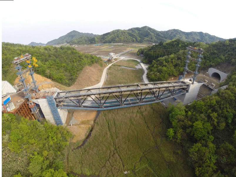
ケーブルクレーン直吊り架設
