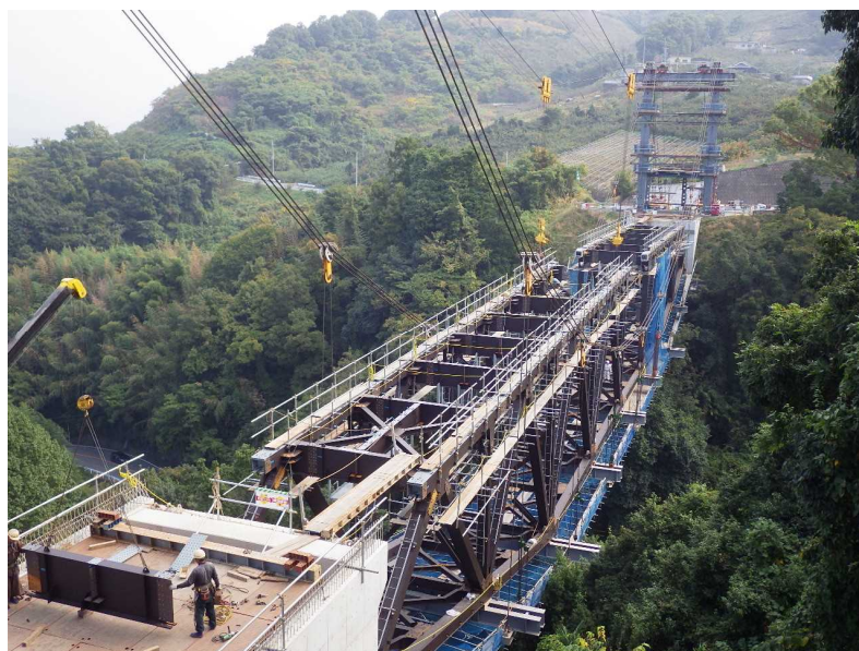
ケーブルクレーン直吊り架設
