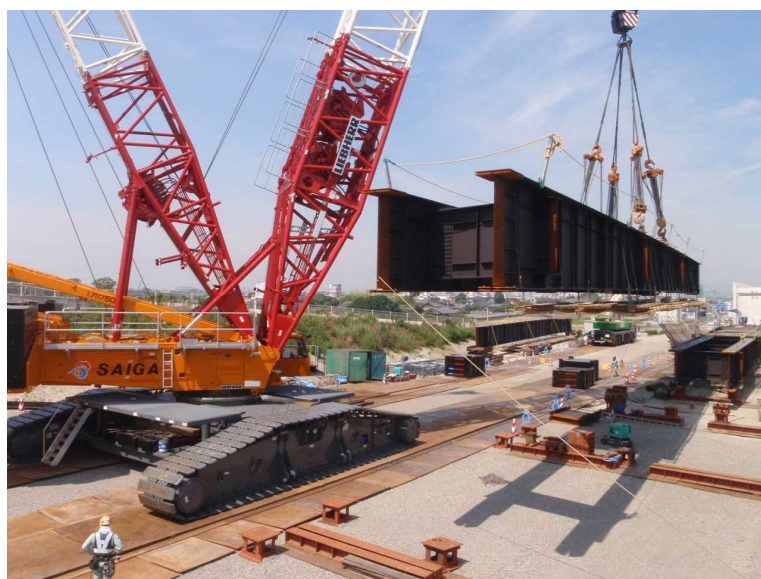
750t吊クローラークレーンによる主桁架設
