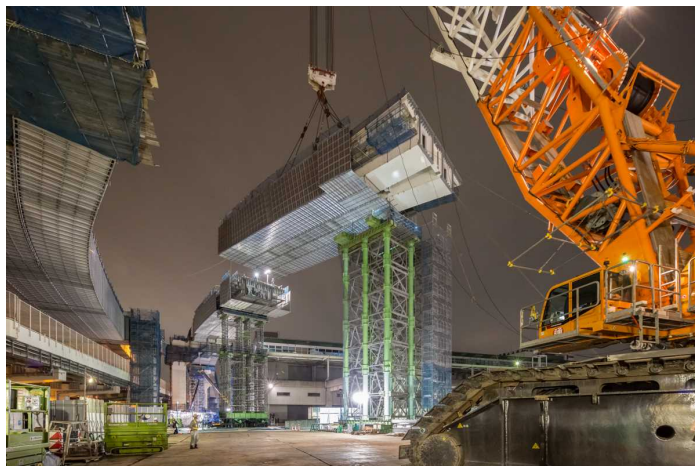
1250 t 吊クローラクレーンによる大ブロック架設
