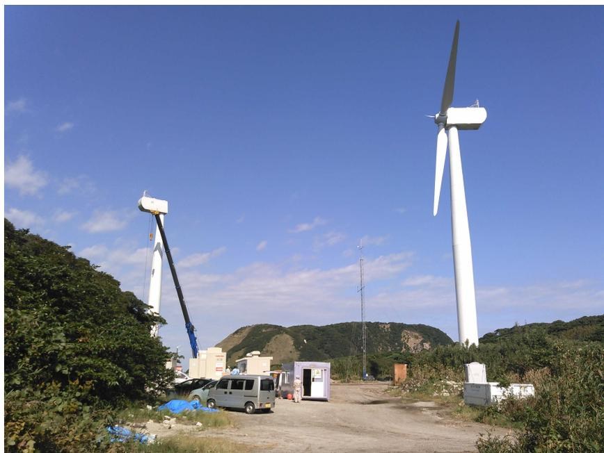
2基目のナセル架設まで完了
