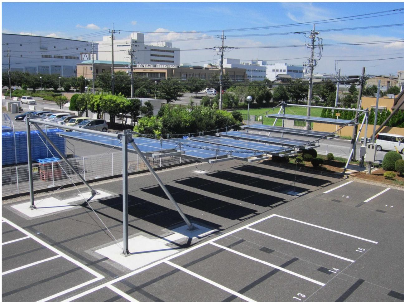
当社テクニカルセンターに設置したケーブル式太陽光発電システム
