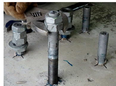
写真-1 Rアンカー抜取り状況
