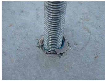
写真-4 引抜き試験後状況 (試験体 a-2)
