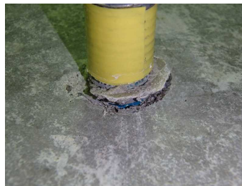
写真-6 引抜き試験後状況 (試験体 b-2)
