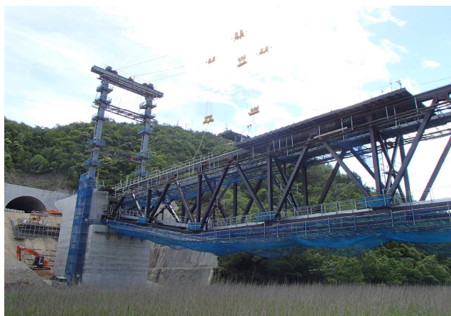
写真-4 合成床版架設状況
