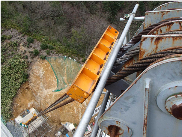
写真-1 脱索防止設備
