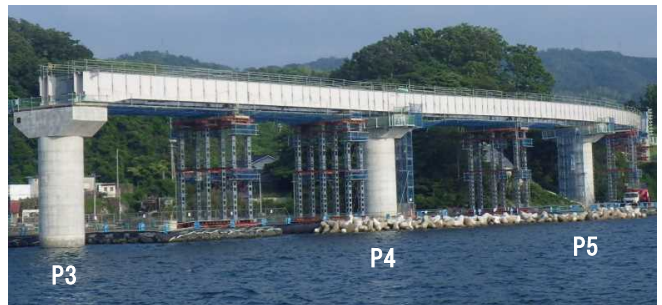
写真-3 架設完了(支点支持)
