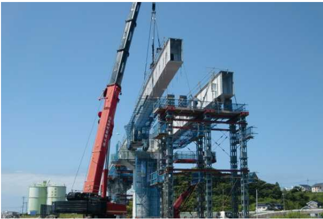
a) 地組立ブロック架設 (P3-P5)
