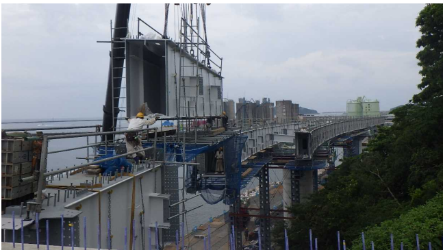
b) 単材ブロック架設 (P5-A2) (落とし込み)
