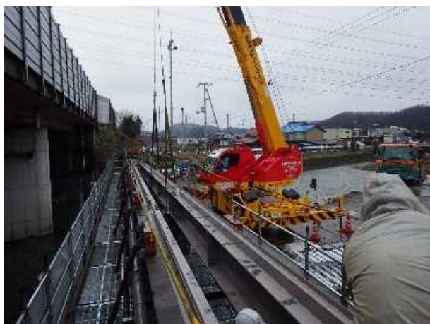
写真-6 桁架設状況
