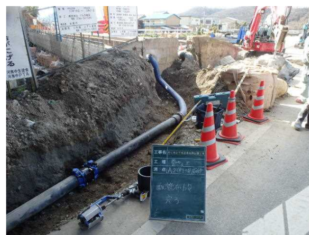
写真-9 新設管布設状況
