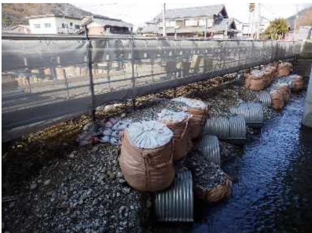
写真-3 足場設置状況
