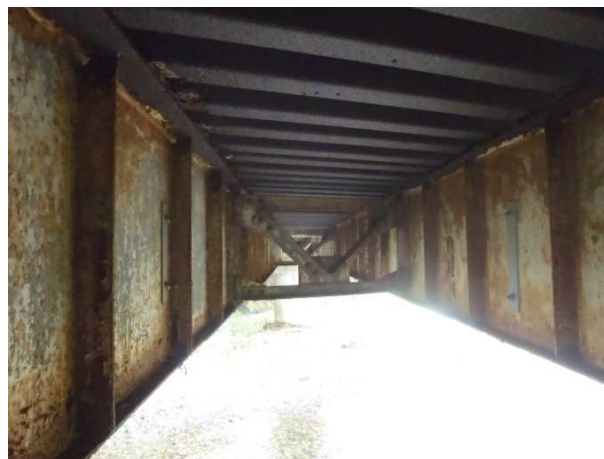
写真-1 旧橋の腐食状況
