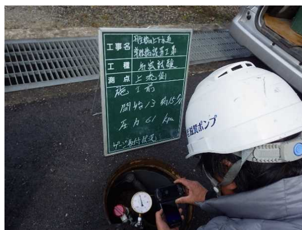
写真-8 気密試験状況
