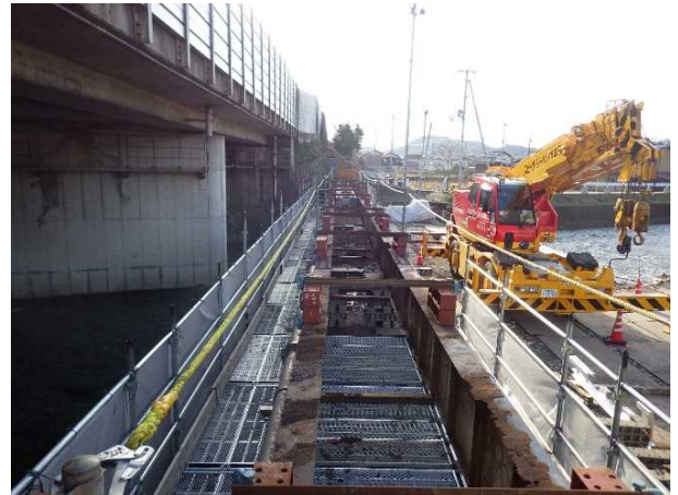
写真-4 旧橋桁仮設間隔保持材設置状況
