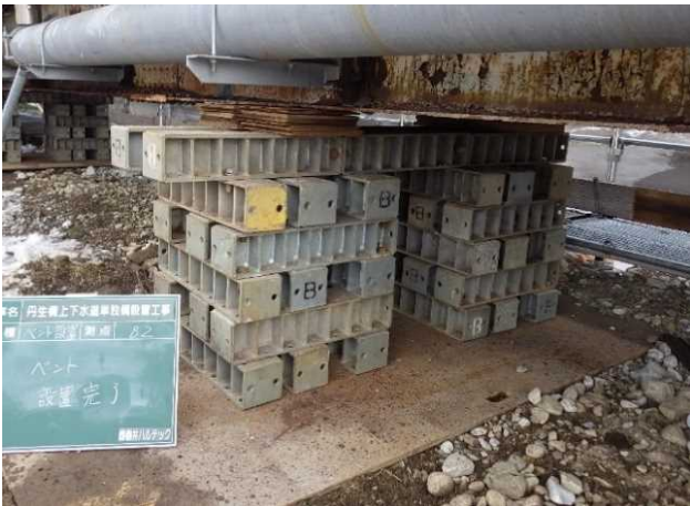
写真-2 仮受ベント設置状況
