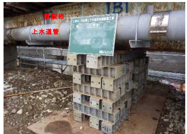
写真-5 既設桁・上水道管仮受状況
