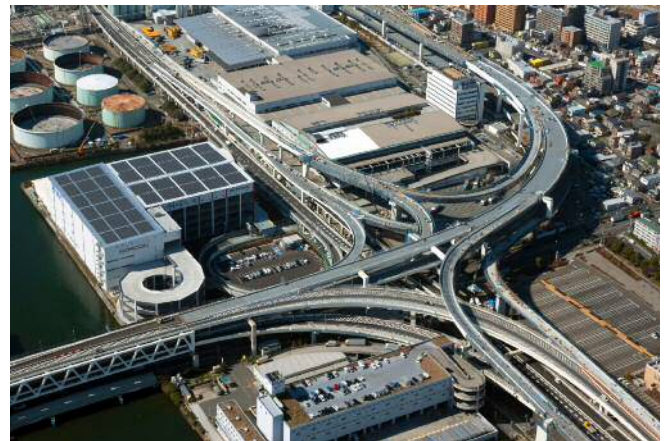
写真-1 生麦 JCT 改築後の全景
