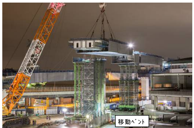
写真-6 PNH1～2間の架設状況
