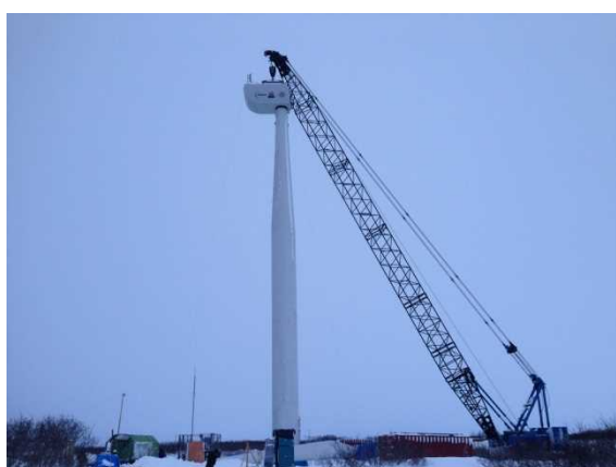
(c) ナセル架設状況
