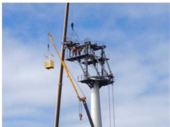
(b) 架設システムの架空組み
