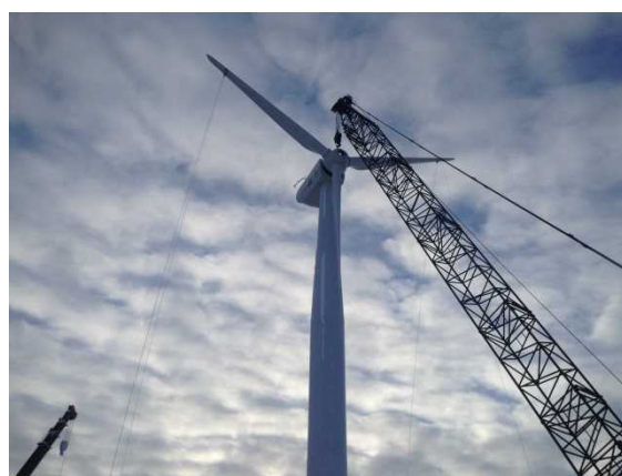
(d) ローター架設状況
