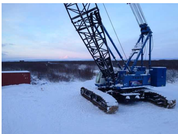
(a) 200t クローラークレーン
