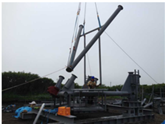
(a) 架設システムの地組み
