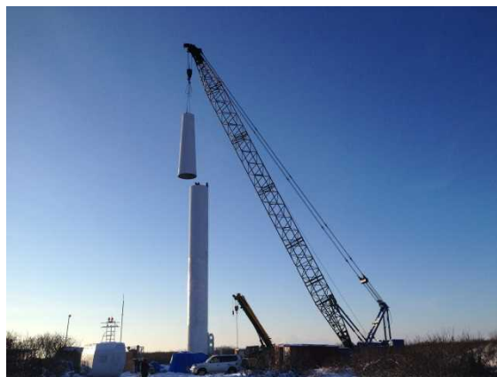
(b) タワー架設状況
