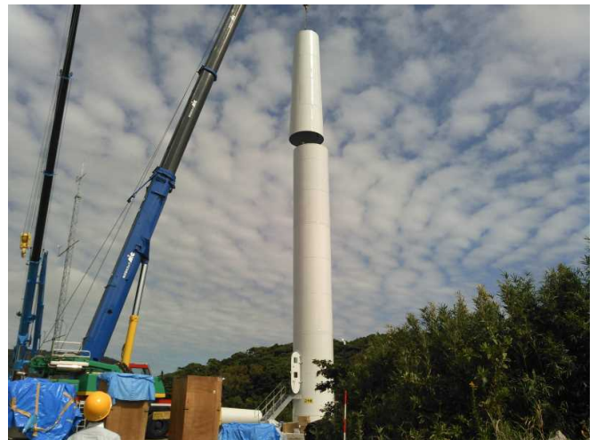
写真-3 タワーの架設状況
