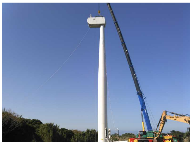
写真-5 ナセルの架設状況
