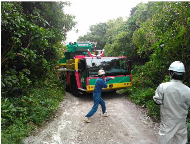
写真-1 クレーンの搬入状況
