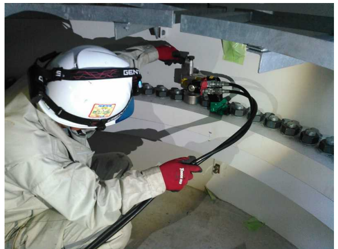
写真-4 タワーフランジの増し締め状況
