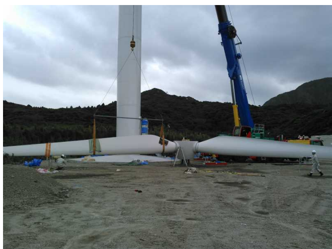
写真-6 ローターの地組立状況
