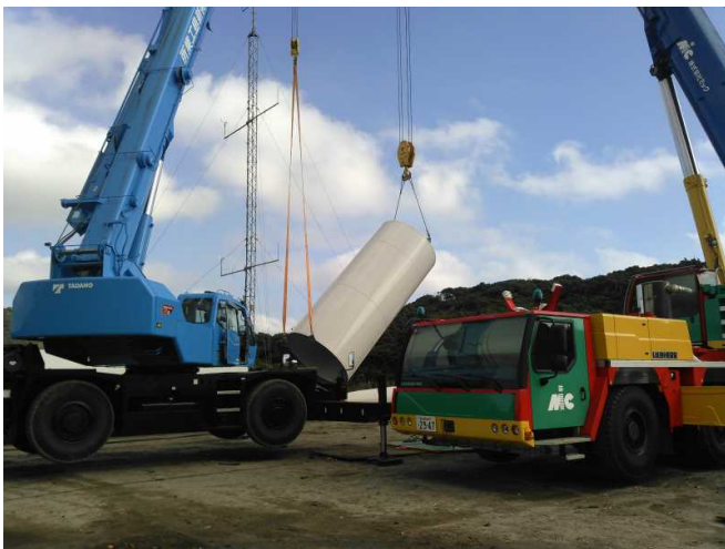
写真-2 タワーの建て起こし状況
