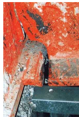
図1 スカラップ底を起点とする破壊 1)
