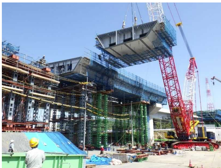
500t吊クローラクレーンによる主桁架設
