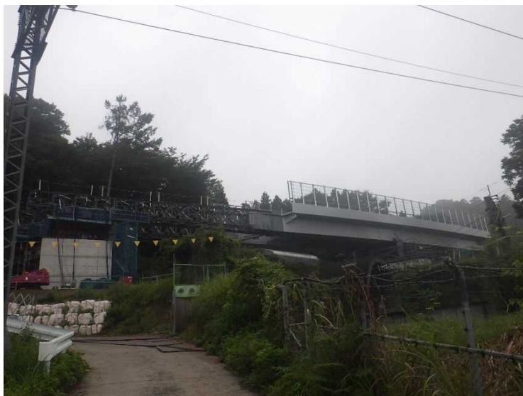
手延べ機を用いた送出し架設
