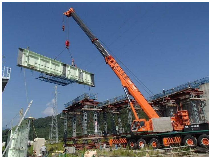
360t 吊オールテレーンクレーンによる主桁架設
