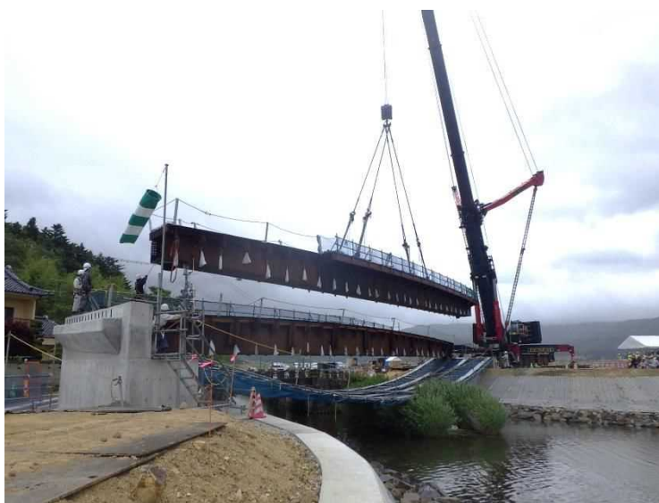
1,200t 吊トラッククレーンによる一括架設
