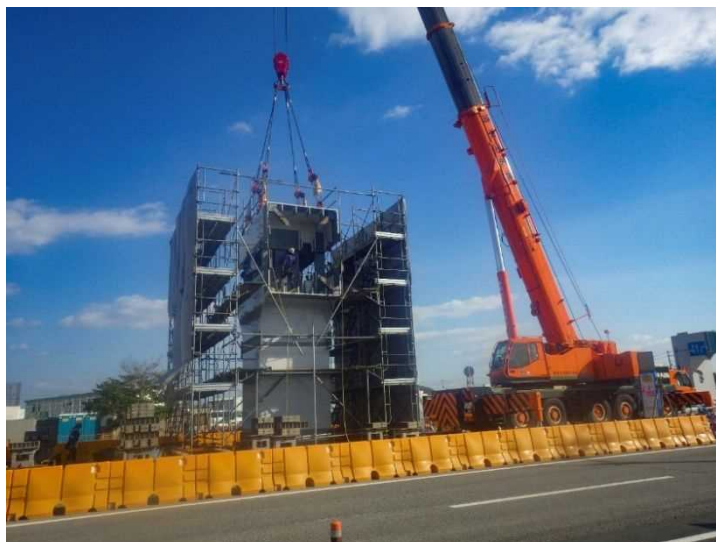
200t吊オールテレーンクレーンによる架設
