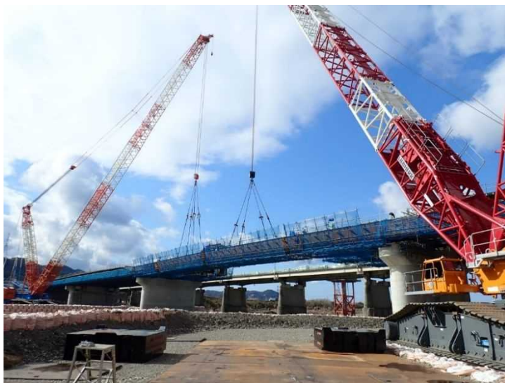
750t吊クローラークレーンによる主桁架設
