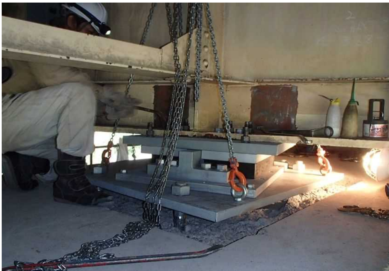
支承取替状況
