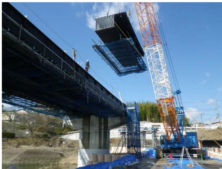
200t吊クローラクレーンによる主桁架設
