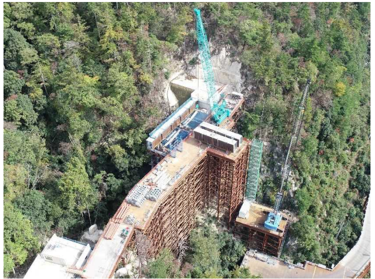
100t 吊クローラクレーンによる主桁架設
