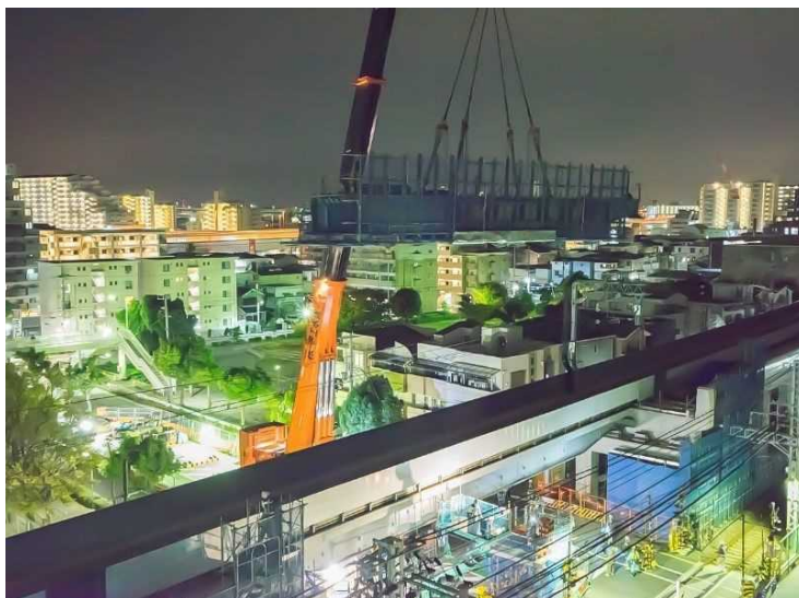
400t吊クローラクレーンによる主桁架設
