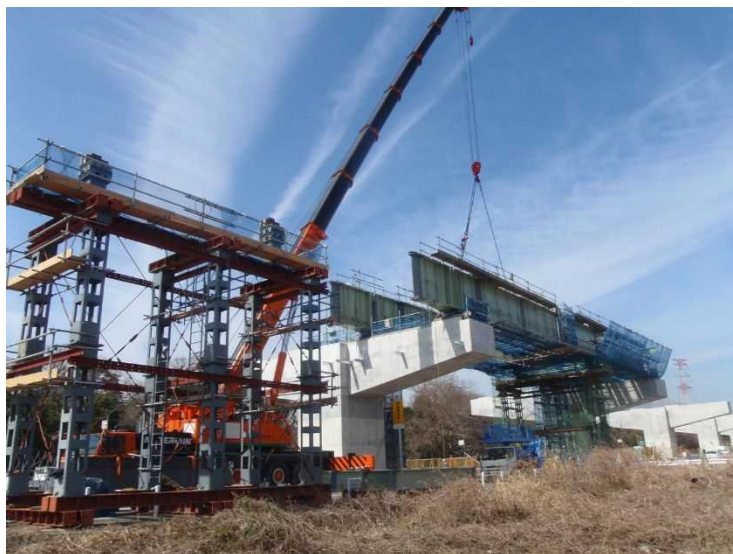
160t吊トラッククレーンによる主桁架設
