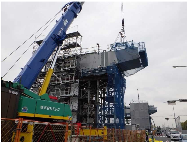
160t吊トラッククレーンによる架設
