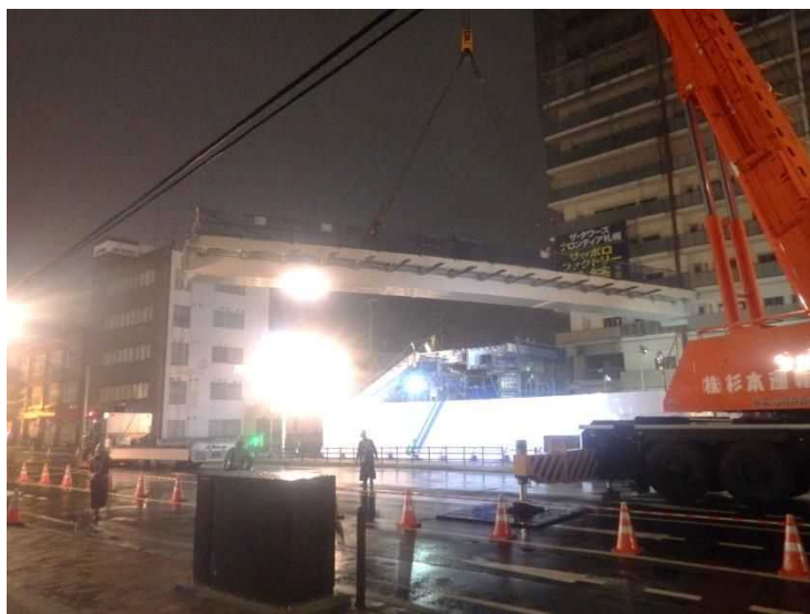
200t吊トラッククレーンによる主桁一括落とし込み架設
