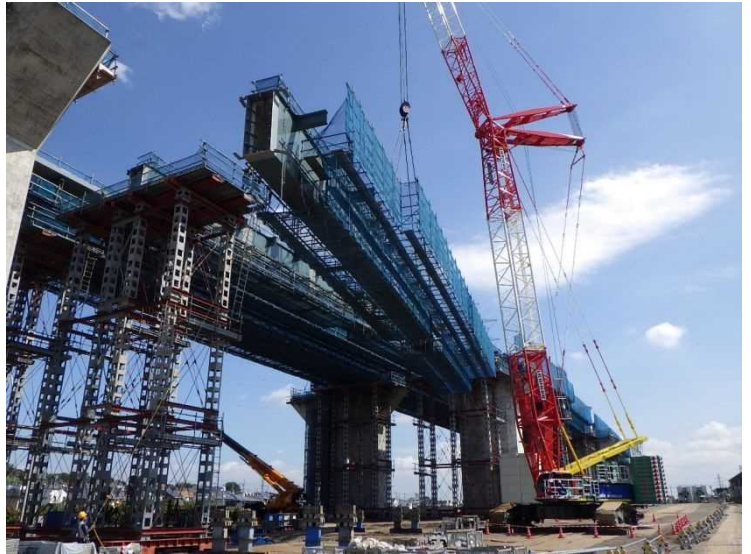
360t吊クローラクレーンによる主桁架設
