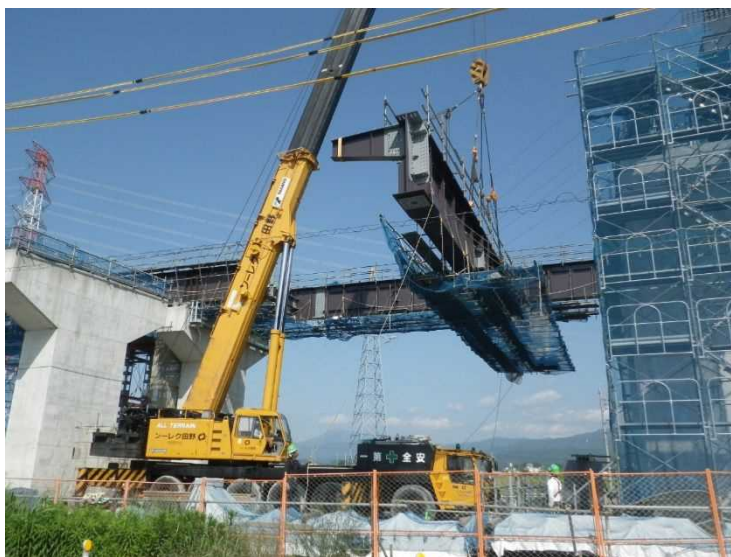
160t吊トラッククレーンによる主桁架設
