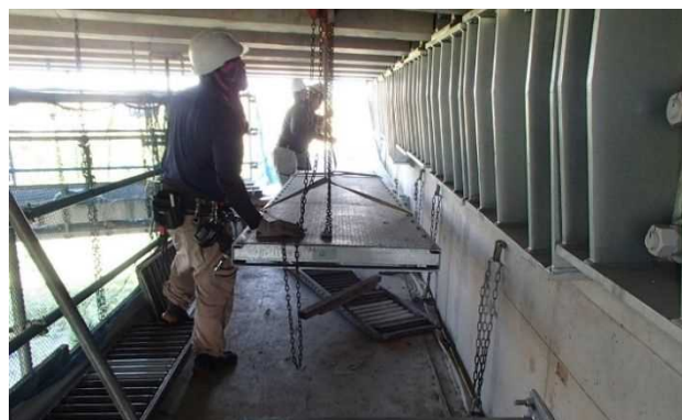
下部工検査路設置工
