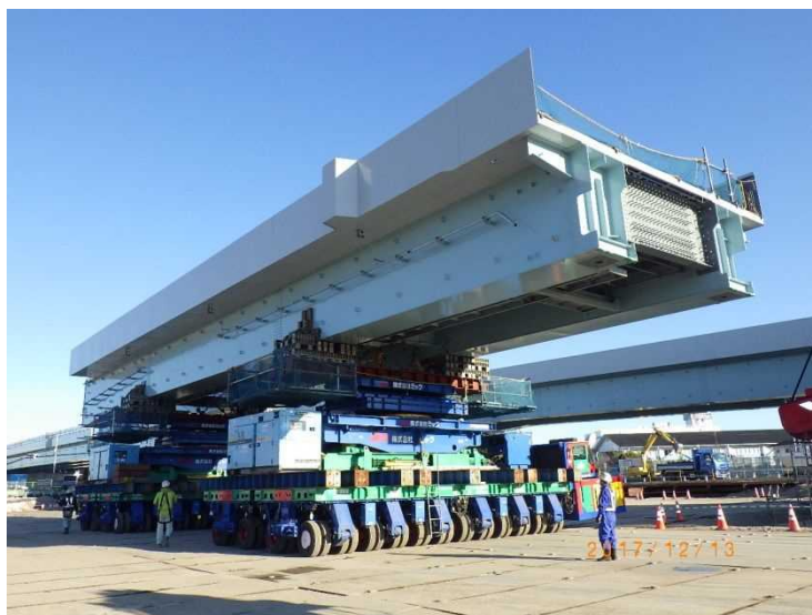
自走式多軸台車による大ブロック一括架設
