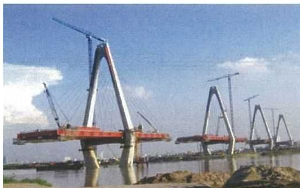
写真-6 ニャットン橋 架設時
