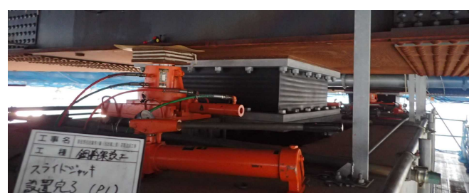
写真-2 スライドジャッキ設置
