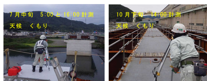
写真-1 仕口間距離計測・仮組立時主桁長計測
