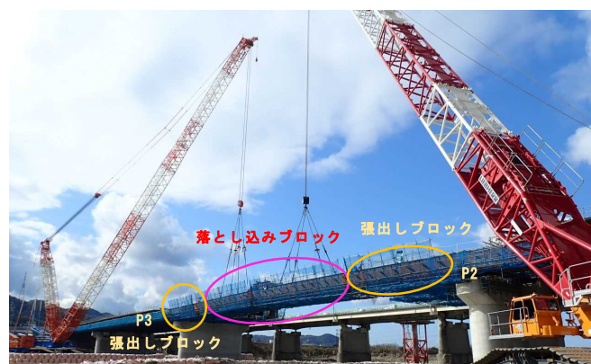
写真-3 架設状況
