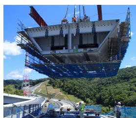
写真-1 J4-J5 架設状況
