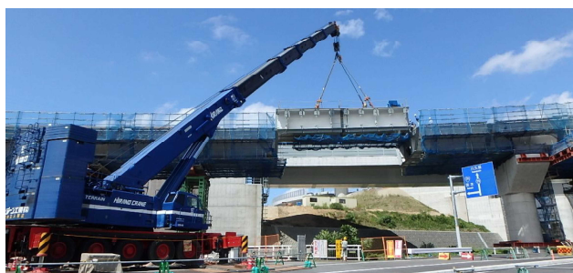
写真-3 J22～J24 架設状況
