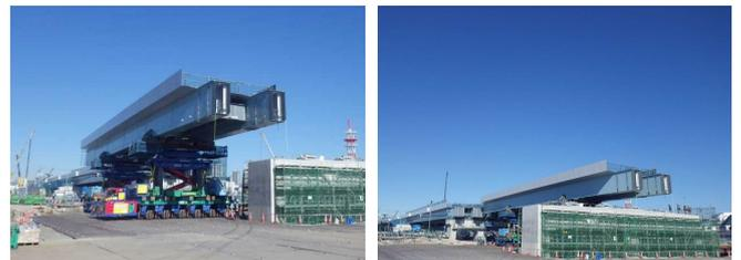
② 搭載運搬、架設+モーメント連結
