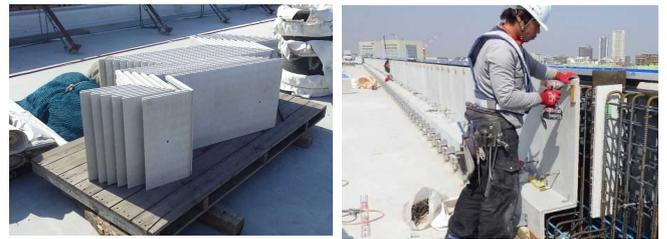
写真-3 埋設型枠(KKフォーム)組立
