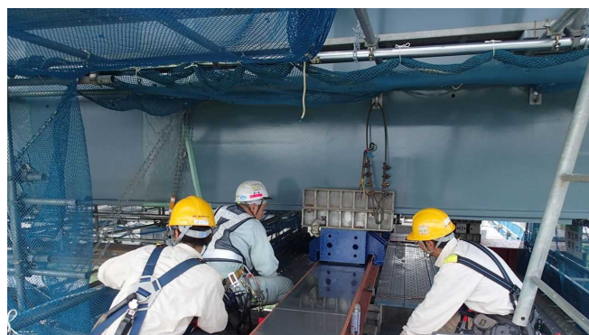
写真-2 横取り架設状況
