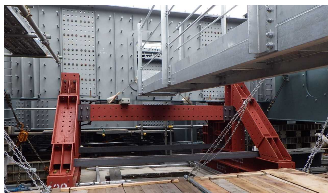
写真-6 鋼桁固定装置
