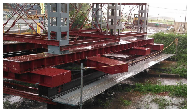
写真-5 ベントの設置（杭基礎）
