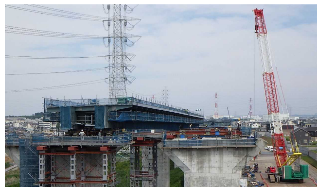
写真-3 横取り架設完了
