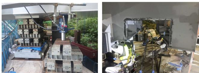
写真-11 サンドル方式降下設備と切り欠き部
