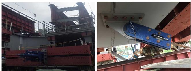
写真-7 ブレーキング・引き戻し装置
