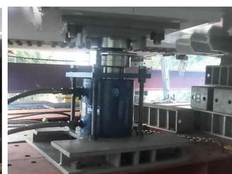
写真-13 G2 桁 S1 支点 回転中心ジャッキ
