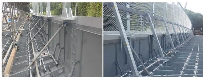
写真-5 受台・補強板および斜材
