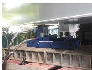
写真-12 G1 桁 S1 支点 横取り装置
