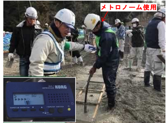
a) バイブレータの挿入時間管理
