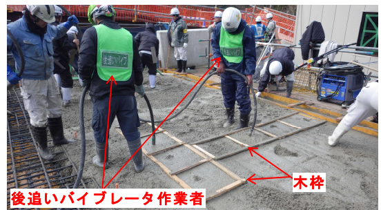
b) 後追いバイブレータ作業者と挿入間隔の管理
