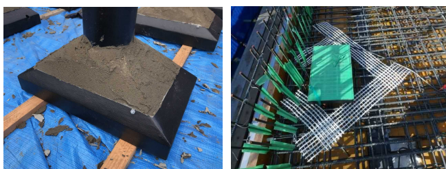
写真-7 排水桝回りのコンクリートひび割れ防止と止水対策
