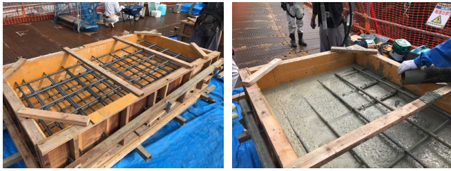
写真-3 縦横断 6%勾配を考慮した供試体
