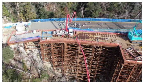
写真-9 床版コンクリート打込み状況
