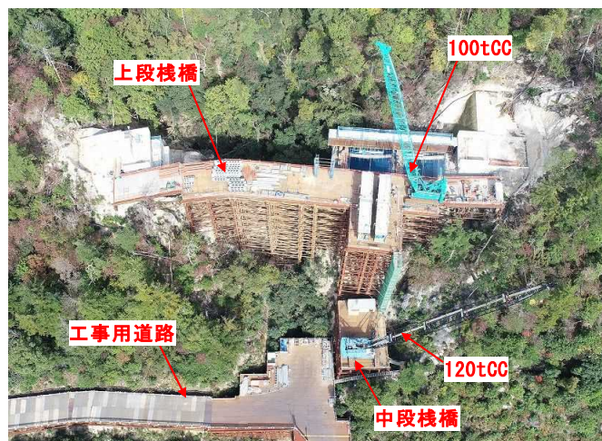
写真-1 栈橋とクレーンの配置状況
