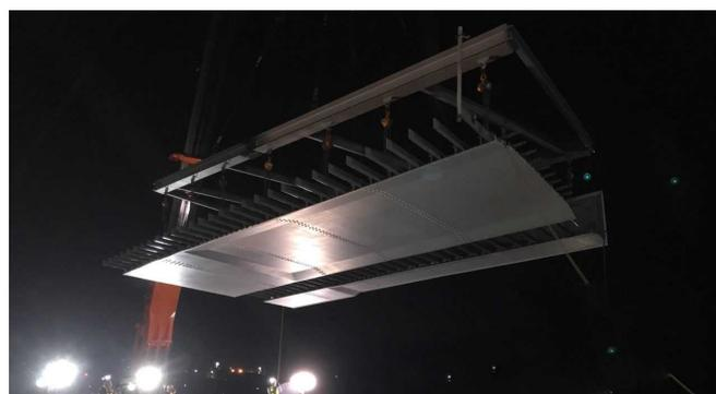
写真-2 合成床版地組架設
