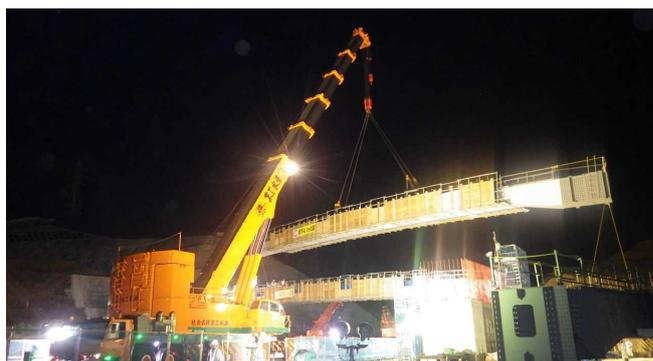
写真-1 夜間鋼桁一括架設
