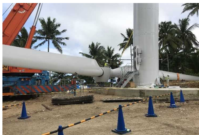
写真-3 ローターの地組立状況
