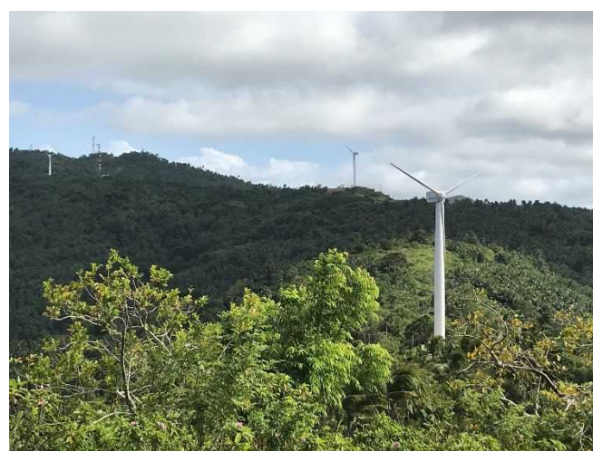
写真-4 完成風景
