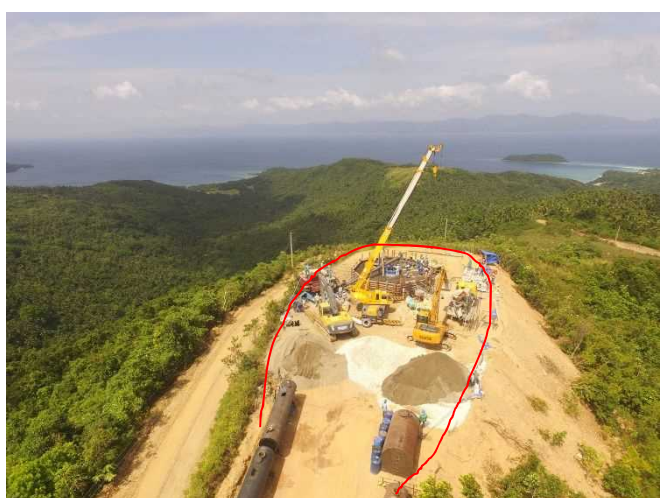
写真-2 現地の施工ヤード状況（3号機）
