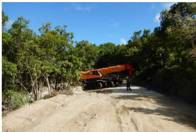
写真-1 クレーンの搬入状況
