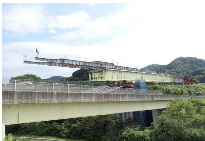
白狐川橋 送出し架設（桁先行式）
