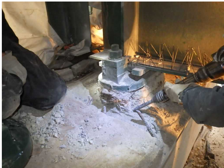
支承取替状況
