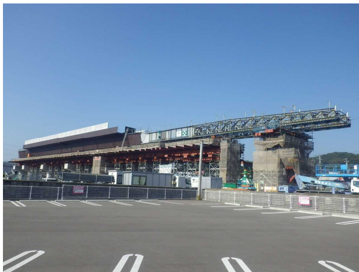
手延機による送出し架設
