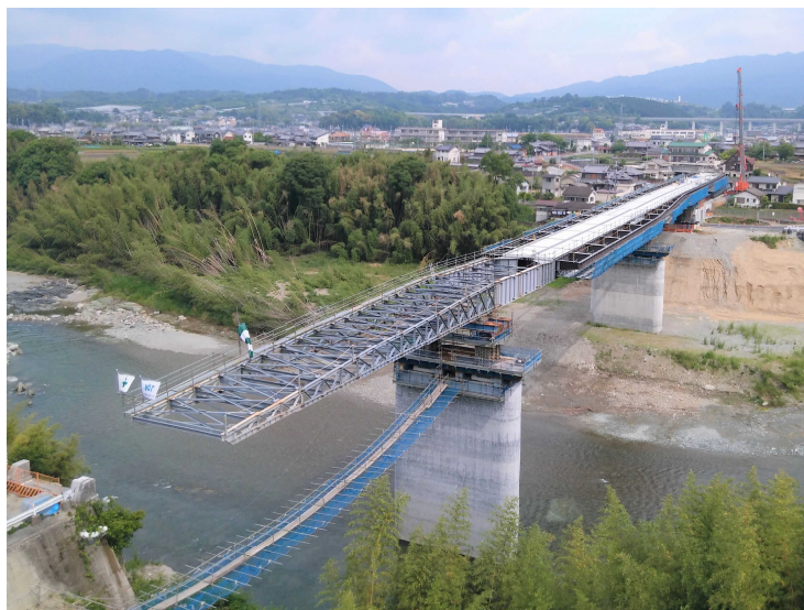
手延機による送出し架設
