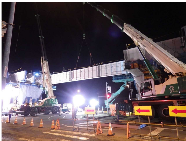
120t 吊トラッククレーンによる主桁架設
