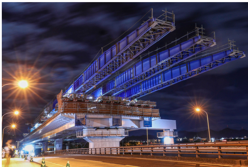
手延機による送出し架設
