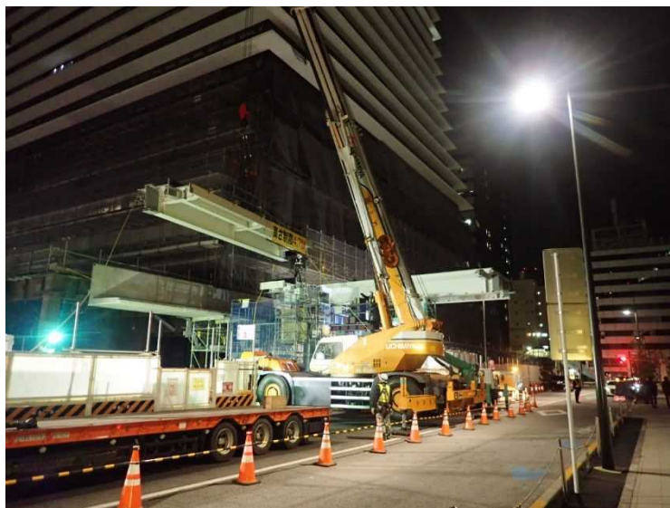
50t吊オールテレーンクレーンによる主桁架設
