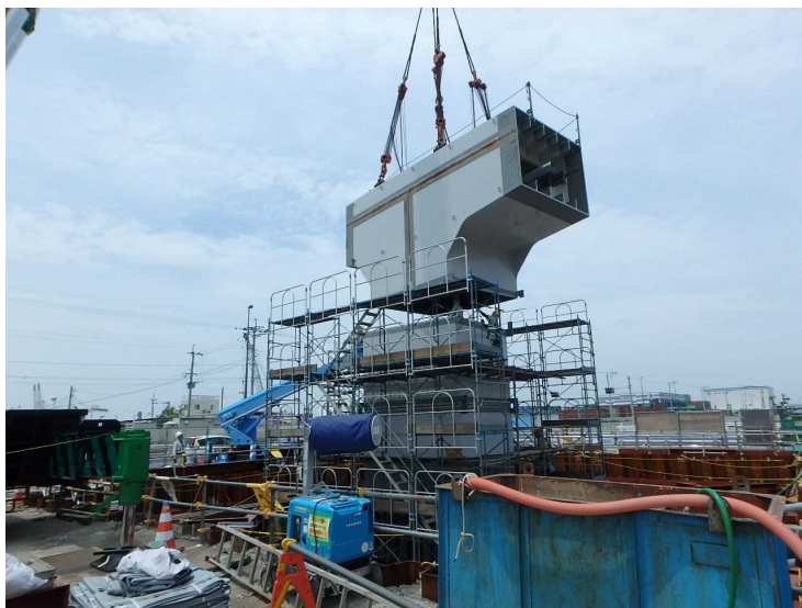
360t 吊オールテレーンクレーンによる架設
