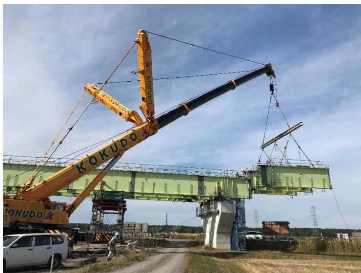
200t 吊トラッククレーンによる主桁架設
