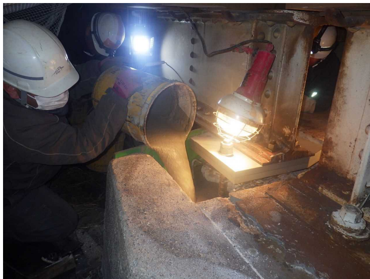
支承取替状況
