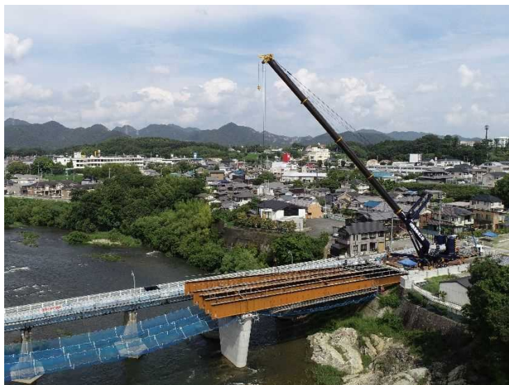
650t 吊オールテレーンクレーンによる主桁架設
