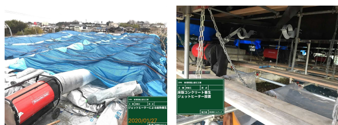
写真-2 ジェットヒーター設置状況
