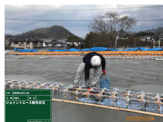
写真-6 打継面処理剤塗布状況
