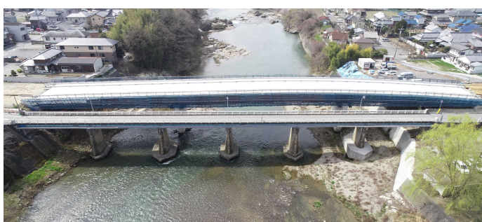
写真-9 完成写真
