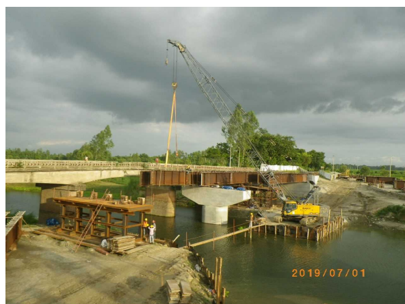
写真-7 Punduria 橋架設状況
