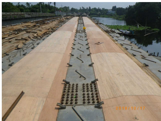
写真-10 床版底面型枠構造
