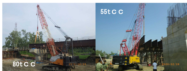
写真-3 使用した80t（左）および55t（右）クローラークレーン
