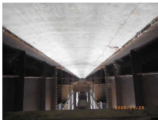
写真-13 型枠解体後
