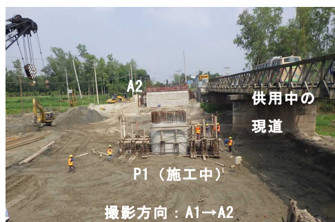
写真-2 Chondi Das 橋下部工施工状況
