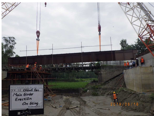
写真-6 Chondi Das 橋架設状況
