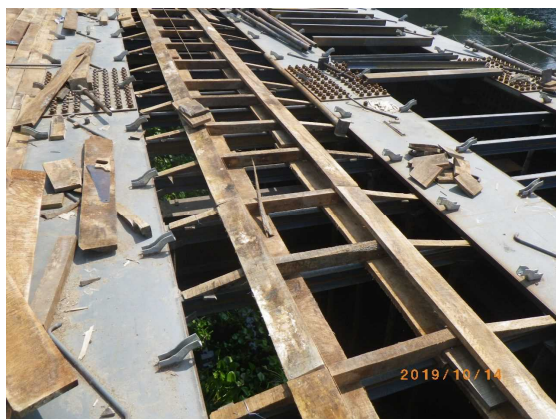
写真-11 床版支保工の組立状況
