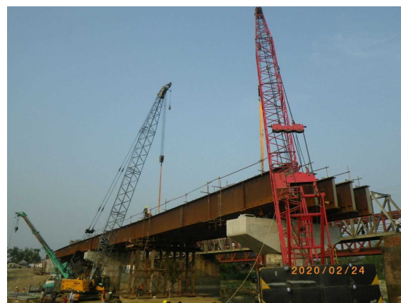
写真-9 Atrai 橋架設状況
