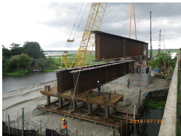
写真-8 Vitapara 橋架設状況
