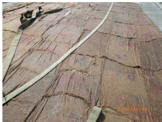
写真-12 コンクリート養生状況
