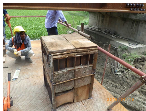
写真-5 サンドル材（桁受け部）
