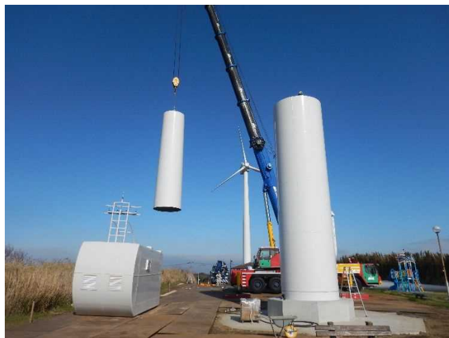
写真-3 タワーの建設状況（2号機）
