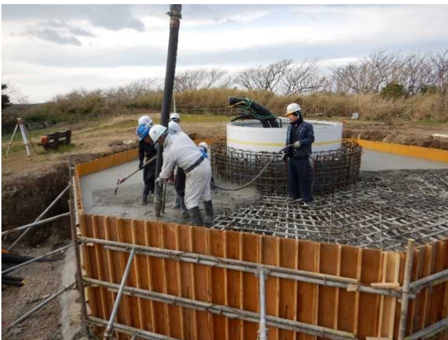
写真-2 基礎コンクリートの打設状況
