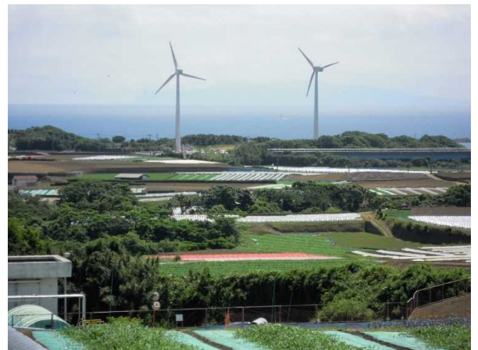
写真-5 工事完了
