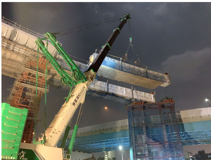
550t 吊オールテレーンクレーンによる主桁架設
