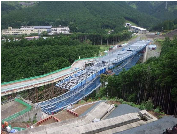
手延機による送出し架設
