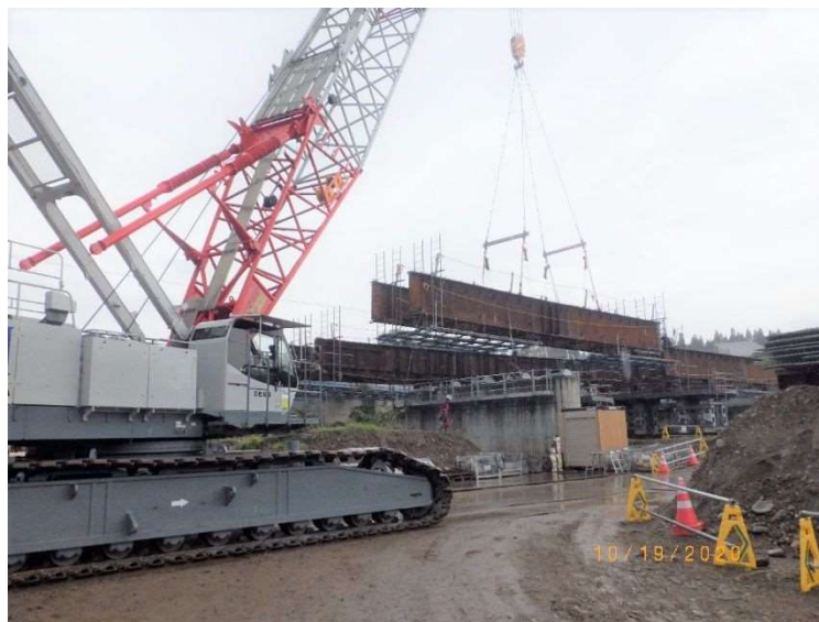
200t 吊クローラクレーンによる架設状況
