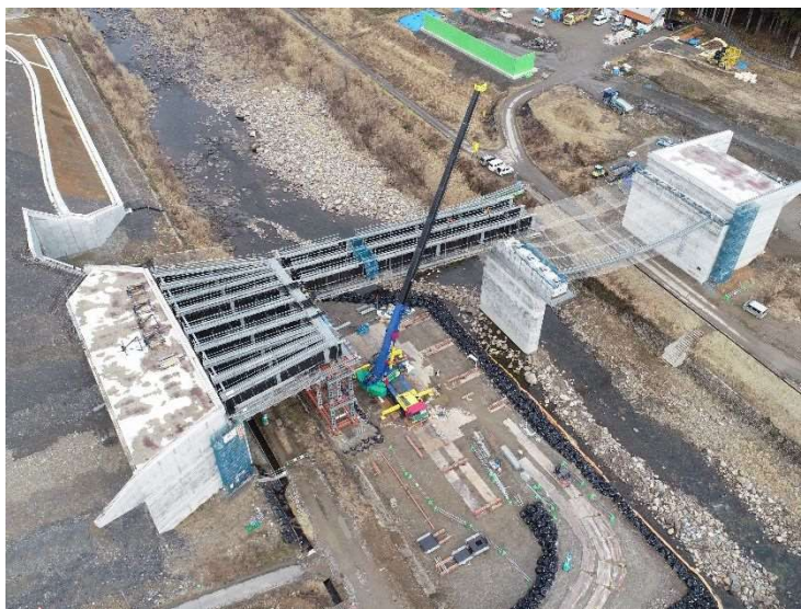
220t 吊オールテレーンクレーンによる主桁架設
