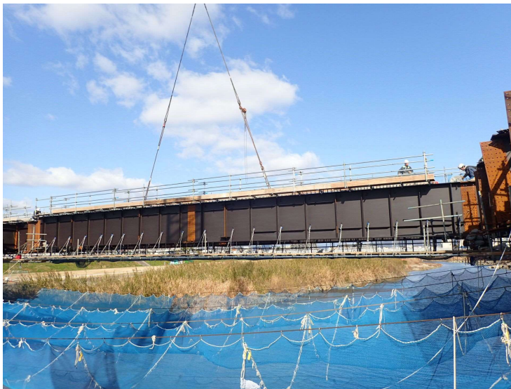
150t 吊クローラークレーンによる主桁架設
