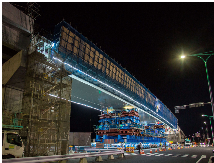
多軸台車による主桁架設
