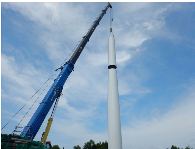
タワー架設状況
