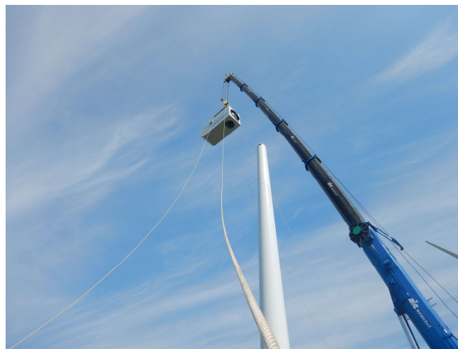
ナセル架設状況
