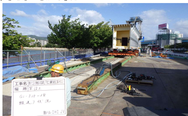
写真-1 桁の縦送り
