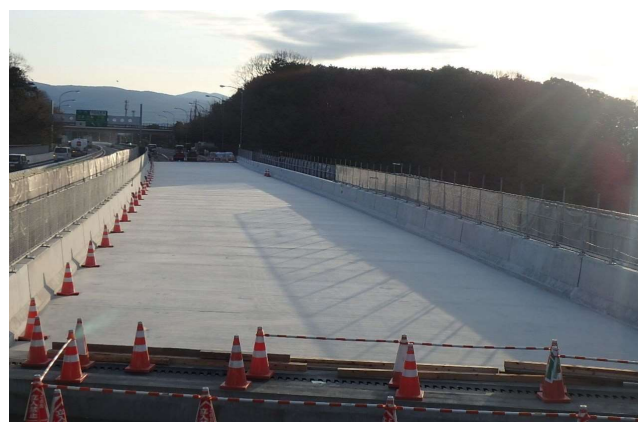
写真-5 PCaPC 床版取替完了
