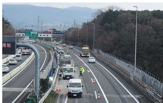
写真-1 車線規制中における準備作業状況
