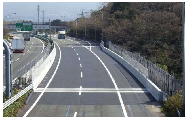
写真-6 愛鷹橋（下り線）工事完成
