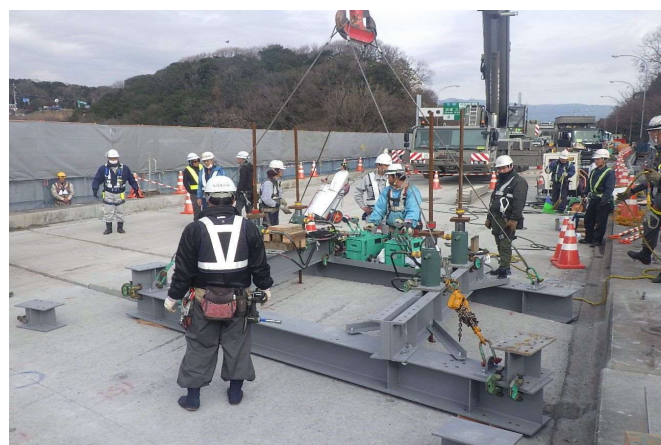
写真-2 床版剥離機による既設床版撤去状況
