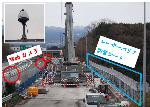
写真-4 安全対策の設置状況 (レーザーバリア、防音シート、Webカメラ)
