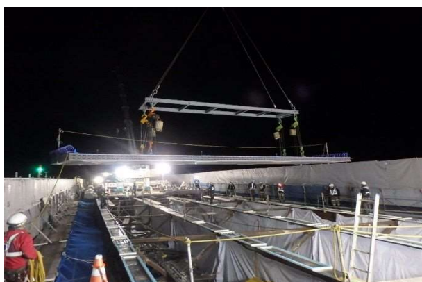
写真-3 PCaPC床版架設状況
